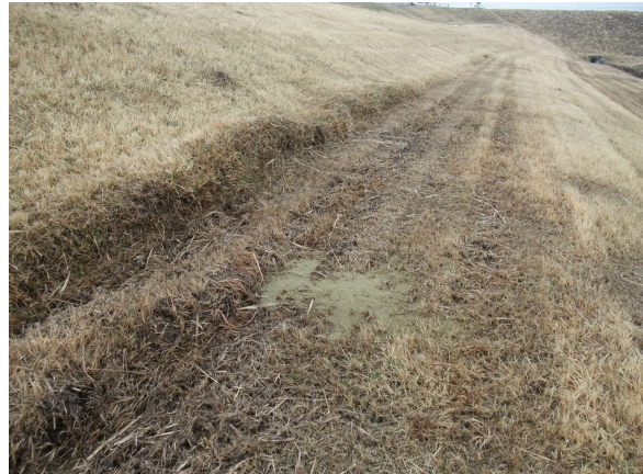
写真7-11 吉田川16.8kmの小段で見られた噴砂
