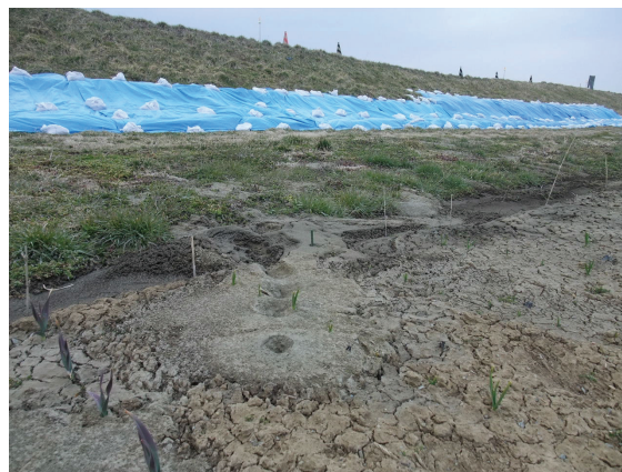
写真 7-9 江合川右岸 19.9km 堤内地 で広く発生した噴砂
