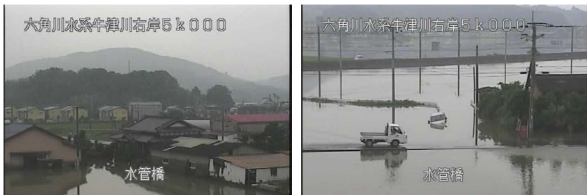
図9.6 平成24年7月13・14日の豪雨による浸水状況の写真（国土交通省提供）
