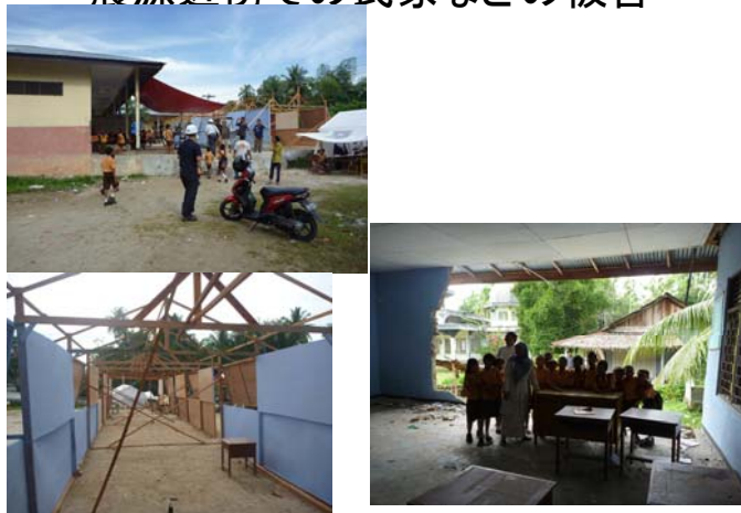
震源近傍での民家などの被害
