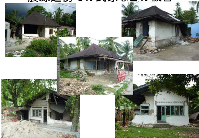
震源近傍での民家などの被害
