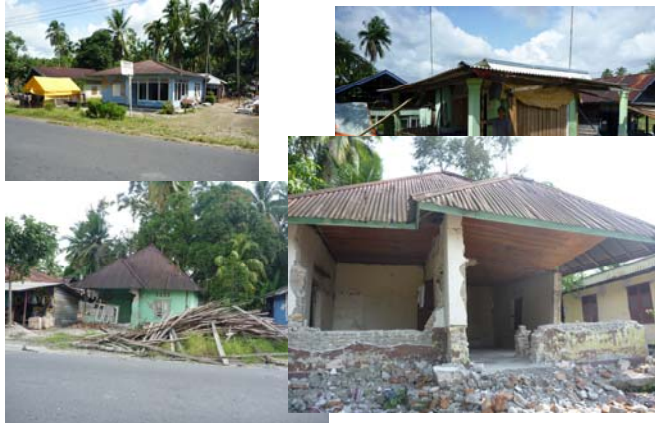
震源近傍での民家などの被害
