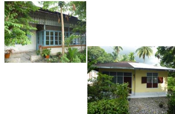
震源近傍での民家などの被害
