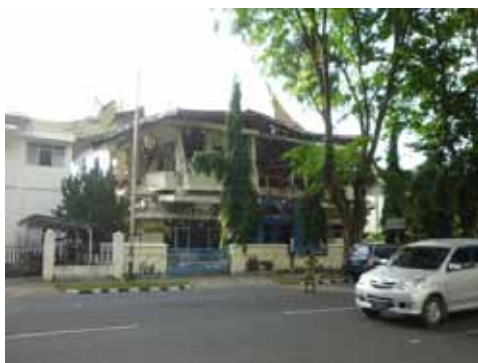
写真 9 中間層崩壊した建物(Area1-3 )
