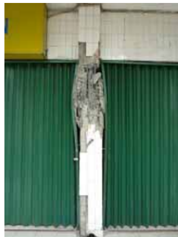
写真 16 せん断破壊 (地図範囲外)
