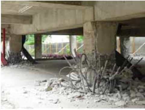
写真 17 圧縮破壊(Area1-1 )
