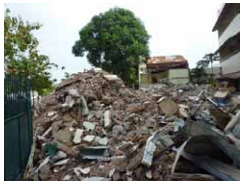
写真 8 完全崩壊した建物(Area1-1 )
