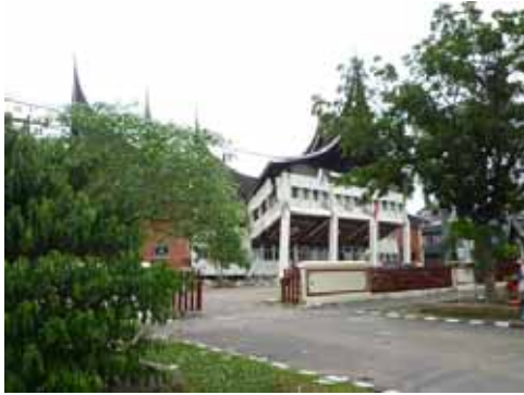
写真 1 層崩壊した建物 (Area 1-3 )
