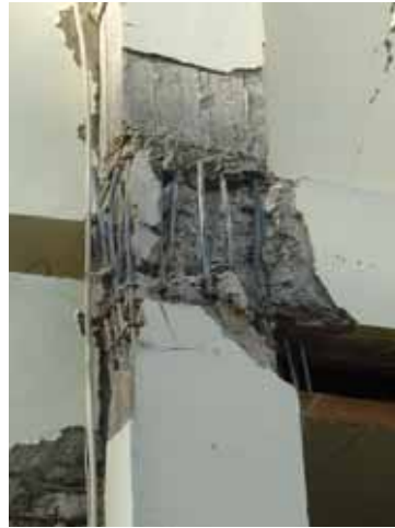
写真 12 柱梁接合部の破壊 (Area1-1 )
