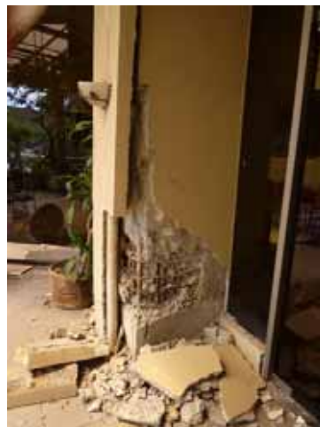
写真 14 曲げ破壊に伴う主筋の座屈 (Area1-1 )
