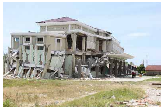
写真 4 層崩壊した建物 (Area 2-2 )
