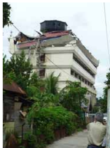
写真 10 最上層が崩壊した建物(Area1-2 )
