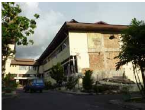
写真 3 層崩壊した建物 (Area 1-3 )
