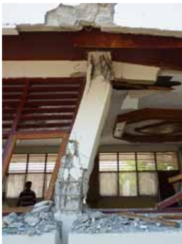
写真 13 曲げ破壊 (Area1-2 )
