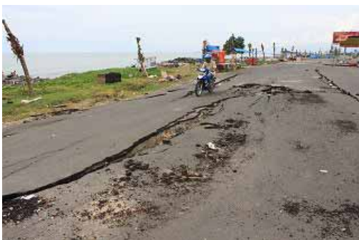
写真 20 海岸通りのひび割れ(Area1-2 )
