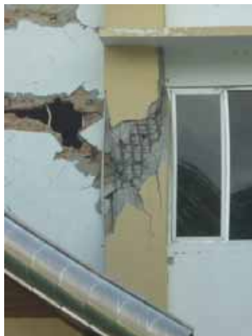
写真 15 せん断破壊 (地図範囲外)
