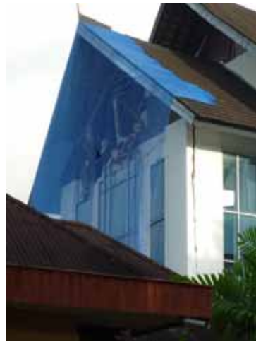
写真 19 非構造壁の破壊
