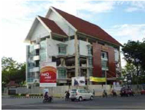
写真 18 非構造壁の破壊(Area1-3 )
