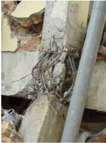
写真 11 柱梁接合部の破壊 (Area1-1 )
