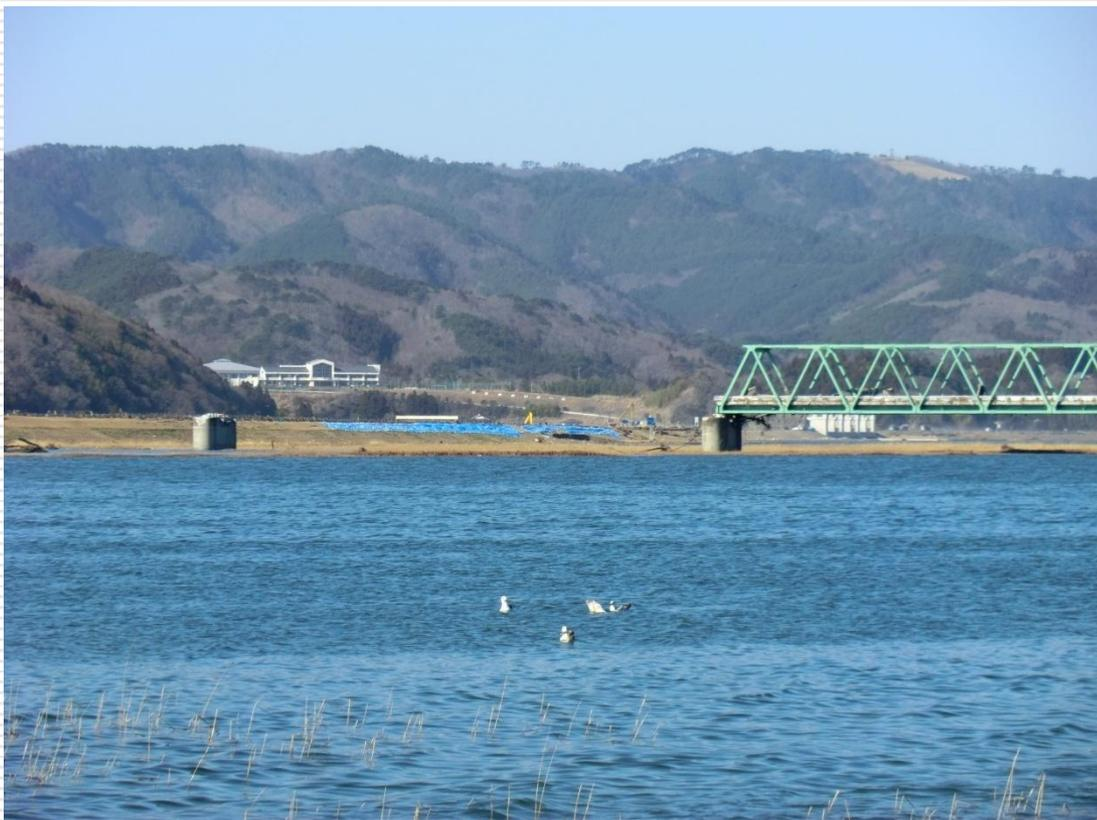
7径間のうち左岸側の2径間のトラス上部工が落ち、上流へ500mほど流された
