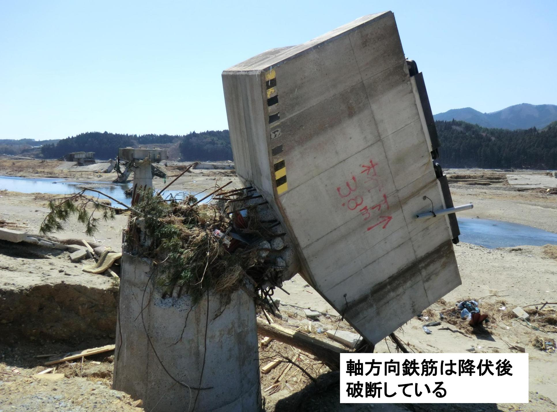
軸方向鉄筋は降伏後
