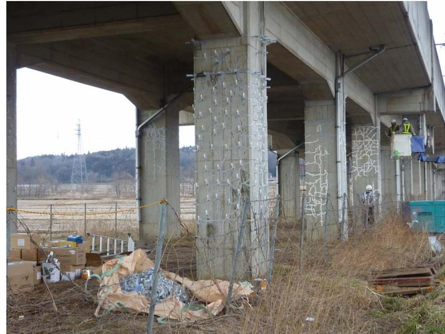
損傷した柱のひび割れ部への樹脂注入
