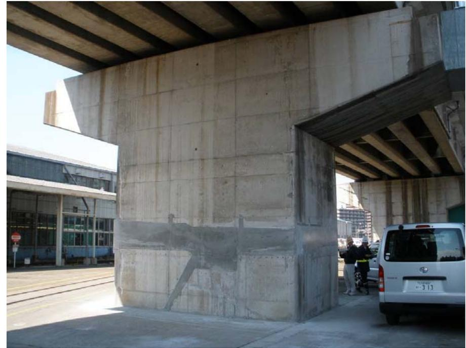
修復状況 (損傷部への帯鉄筋の配置と無収縮モルタルによる断面修復)
