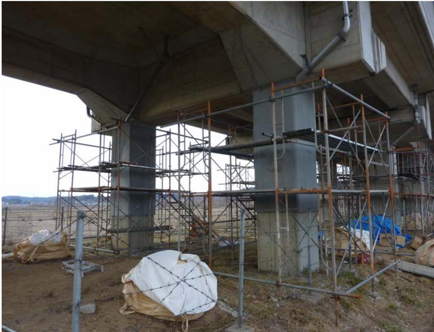
ポリマーによる損傷した柱の断面修復
