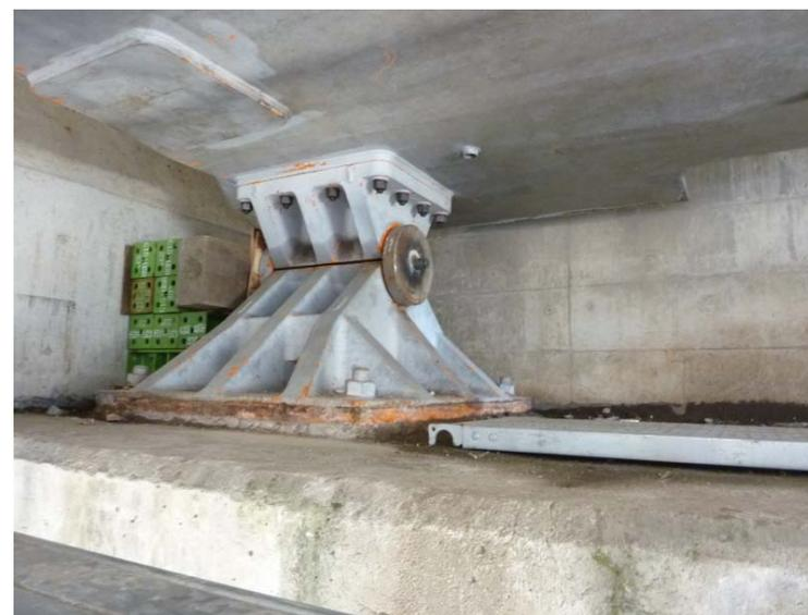
支承ピンの破断, 橋軸直角方向への移動
