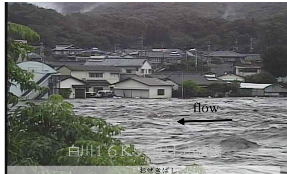
(d) 白川 16k900 地点 (小碓橋) 付近の被災状況 (国直轄管理区間)
