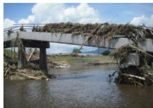
(a) 上流側からの様子
