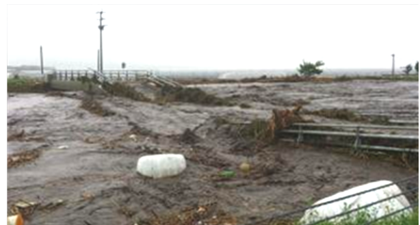
写真 3.1 7月12日における鷲の石橋の状況 (提供：阿蘇市)
