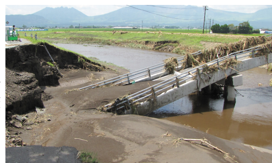
(b) 橋脚と橋台の沈下の様子
