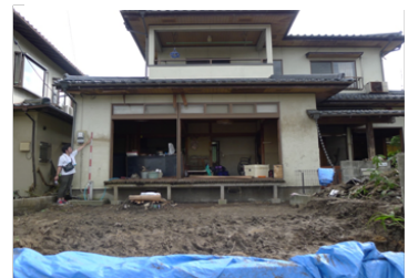
(c) 水衝部近傍の家屋被害 (地点 C) 盛土高: 1.0m, 浸水深: 1.8m 撮影: 2012.07.15
