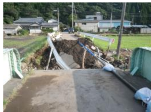
写真 3.4 代官橋の被害状況 (7 月 15 日撮影)
