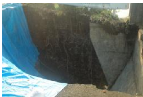
(b) 橋台付近
