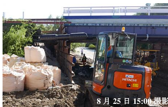
図 5.3.3 清見橋（仮設橋）の右岸橋台裏の被災状況
