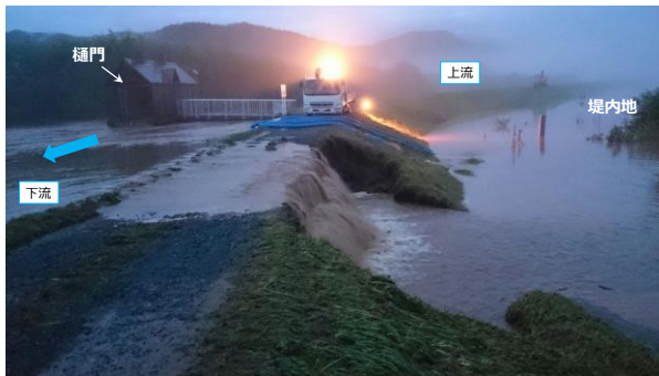
図 5.2.19 越流時の状況（8月22日4時頃の状況）
