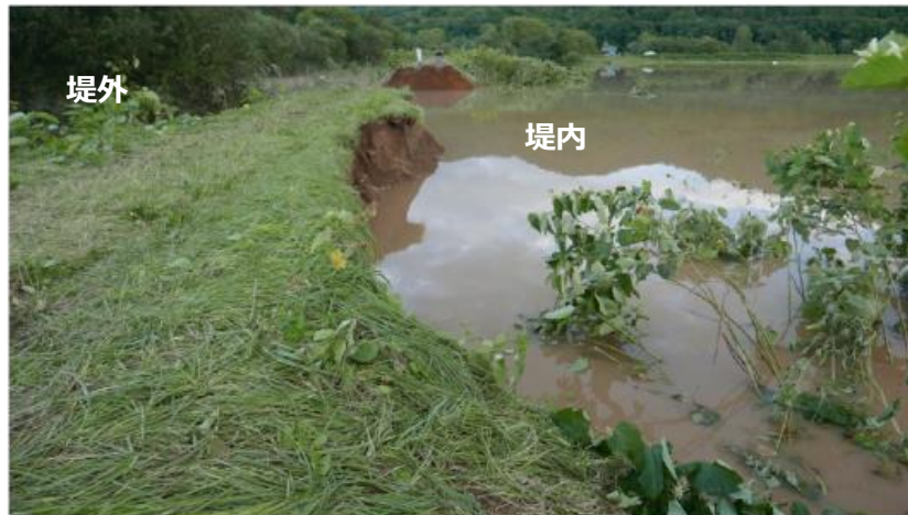
図 5.2.11 現地の全景写真（東亜川上流側から撮影）
