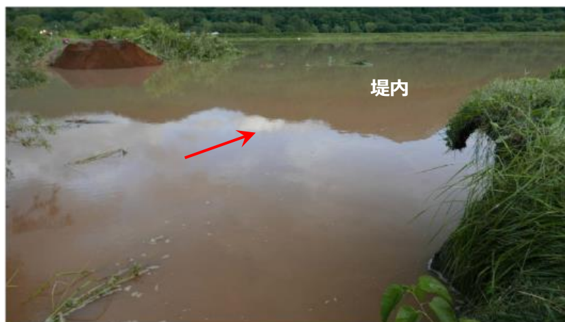
図 5.2.13 東亜川河川水の流出状況
