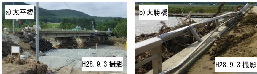
図 3.3.7.1 空知川 幾寅地区における橋脚の流木捕捉状況
