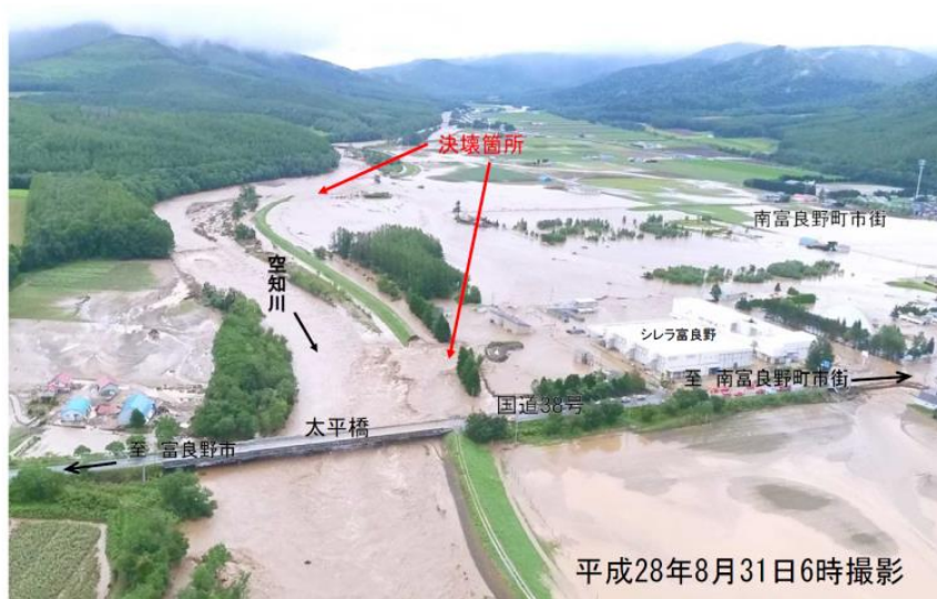
図 3.3.1.1 空知川の破堤（南富良野町）
