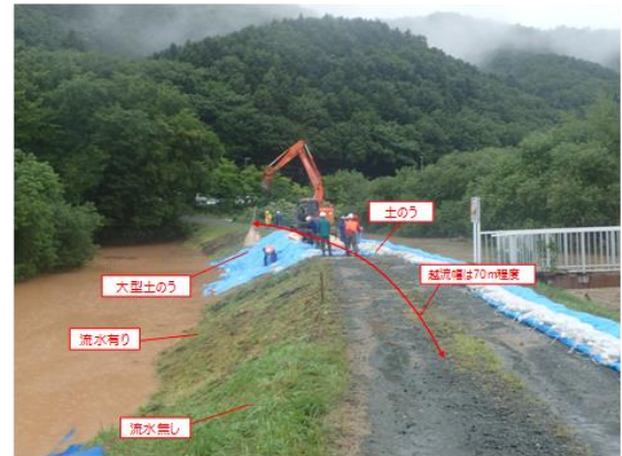
図 5.2.20 応急対策の状況（8月22日14時頃の状況）
