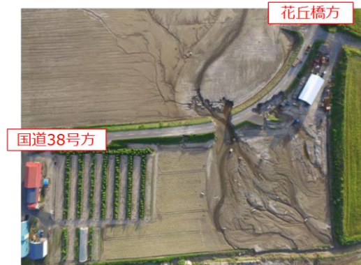
図 5.3.10 ドローン空撮による現地状況
