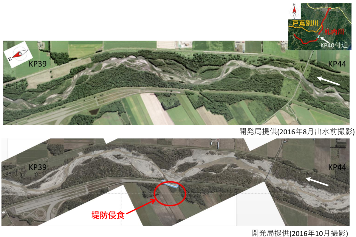
図4.2.1 出水前後の札内川 KP40km 付近、上) 2016年8月出水前、下) 2016年8月出水後
