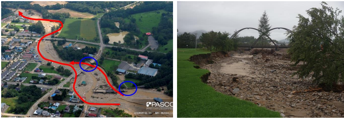
図 4.4.5 下流側の被災区間における河岸決壊状況、左) 石山橋周辺 (9/1 撮影、左右岸の連続的な河岸決壊状況)、右) 石山橋下流 (9/6 調査団撮影、河岸決壊の状況)
