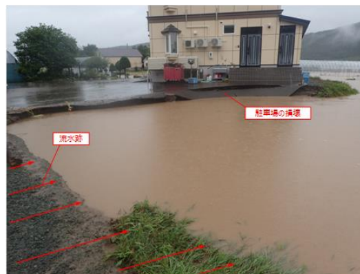
図 5.2.16 民家付近の状況
