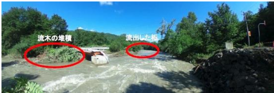
写真1 現場全体状況（右：右岸、左：左岸）
