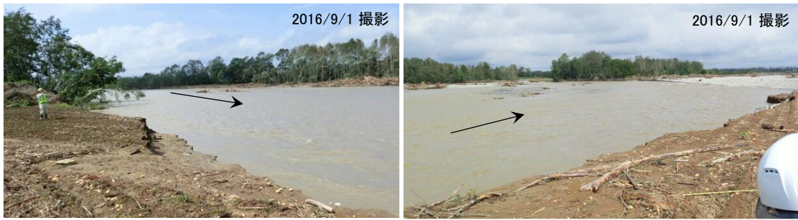
図 4.1.3 戸蔦別川右岸堤防決壊箇所（左：上流を望む；右：下流を望む）
