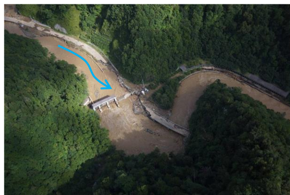
図 6.3.2.6 ニセクシュマナイ橋の路盤流出
