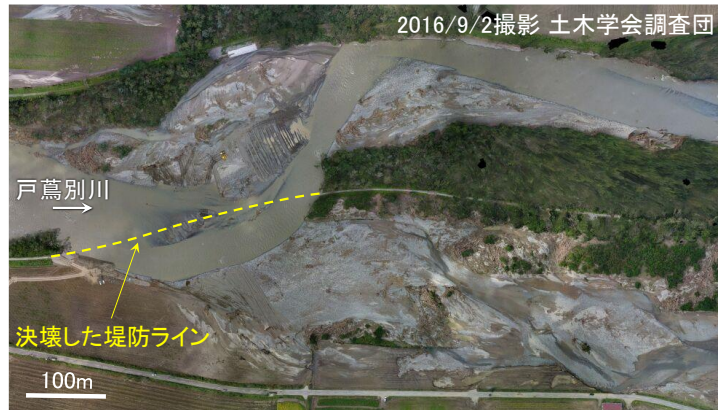
図 4.1.4 戸蔦別川右岸堤防決壊箇所（ドローン空撮によるオルソ化画像）
