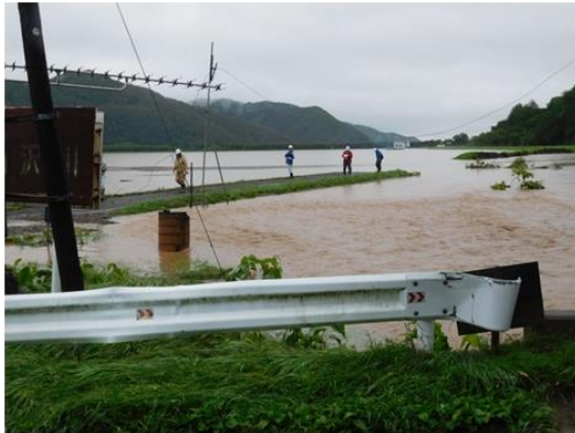
図 5.2.14 堤体の流出状況①
