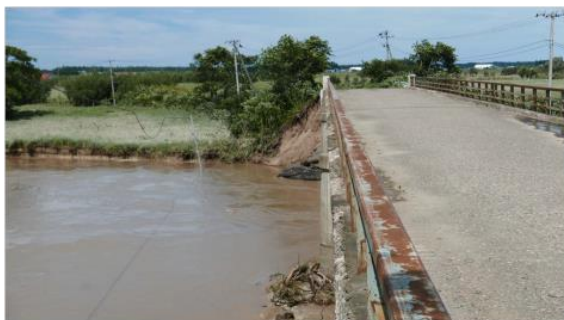
図 5.2.5 太幌橋の全景（右岸橋上から撮影）
