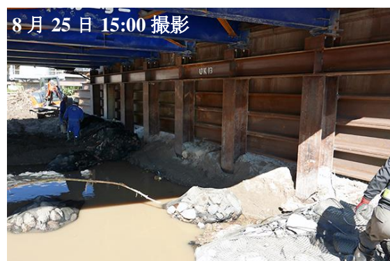
図 5.3.3 清見橋（仮設橋）の右岸橋台裏の被災状況
