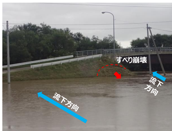
図 5.2.2 共立橋左岸橋台の状況
