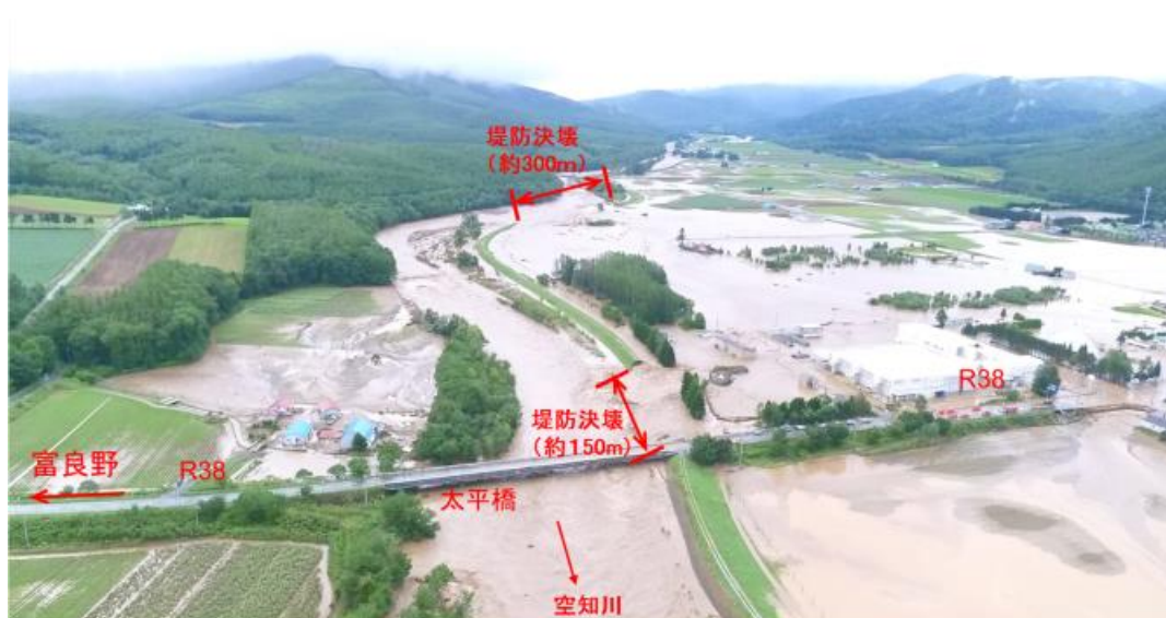
図3.1.13 破堤後の氾濫状況写真(8月31日撮影)
