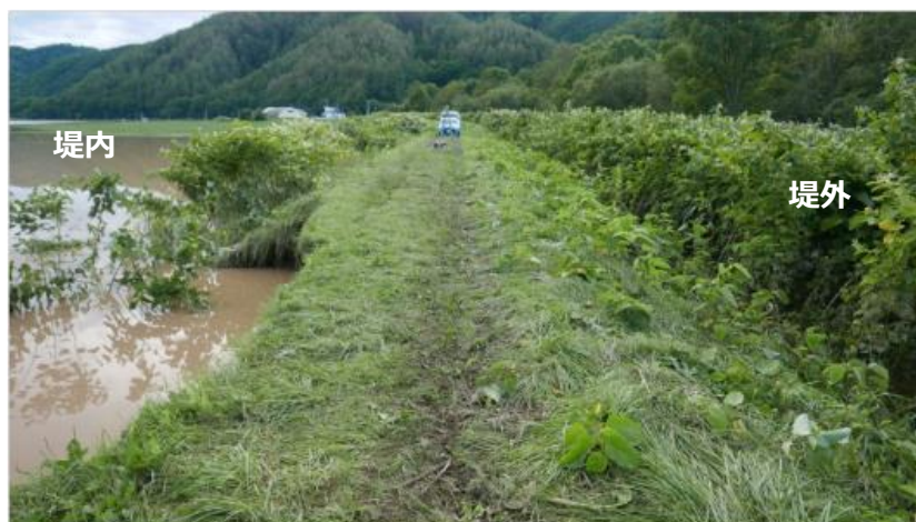
図 5.2.12 現地の全景写真（東亜川下流側から撮影）
