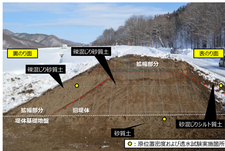
図 5.2.17 開削調査時の断面および現場密度・透水試験の実施箇所
