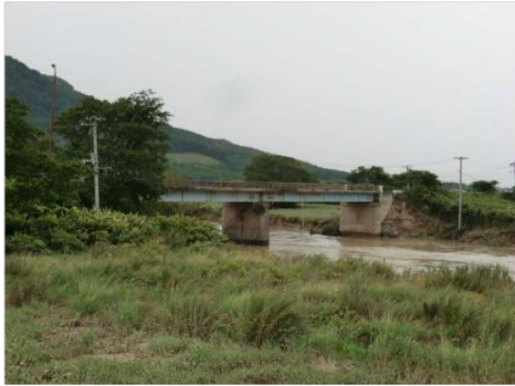
図 5.2.3 太幌橋の全景（右岸下流から撮影）
