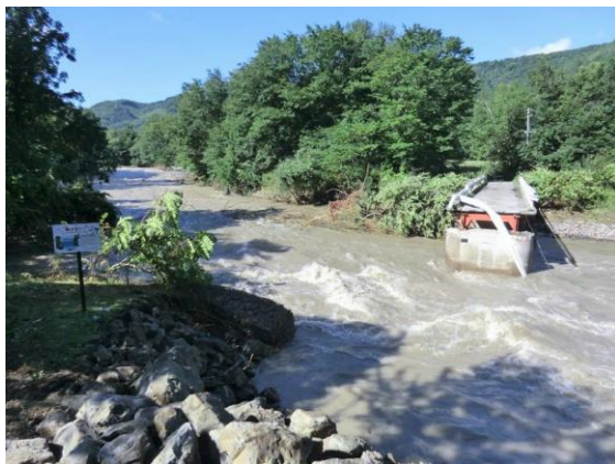
写真2 右岸より上流側
