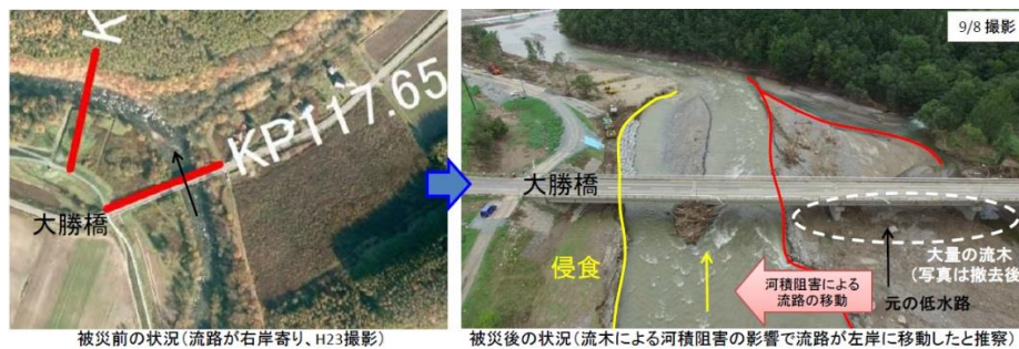
図 3.3.7.4 大勝橋付近の様子(左:被災前, 右:被災後) 4)
