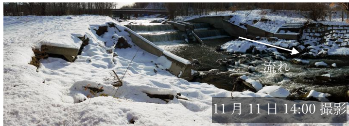
図 5.3.15 無加川第5落差工の被災状況
