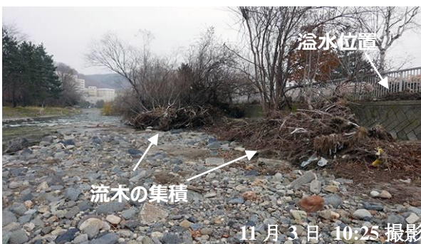
図 5.3.7 溢水箇所下流の流木の集積
