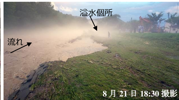
図 5.3.6 水郷大橋下流右岸の溢水による侵食
