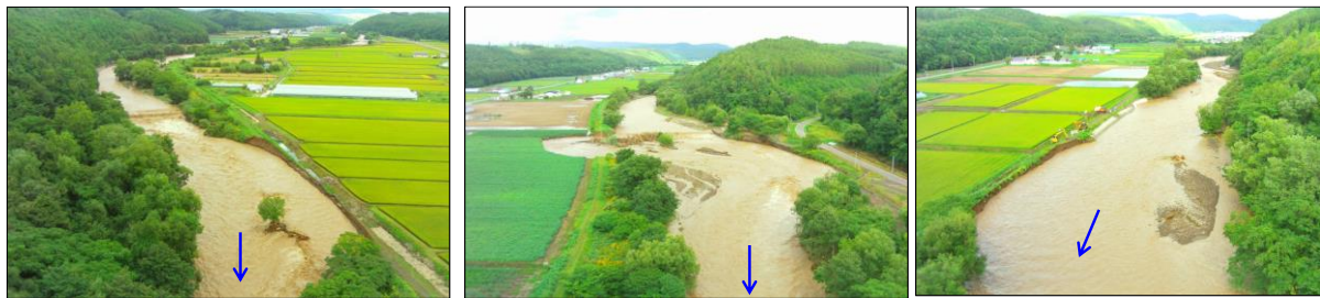
図 3.2.2 河岸侵食状況 (指定区間, 提供: 北海道開発局)
