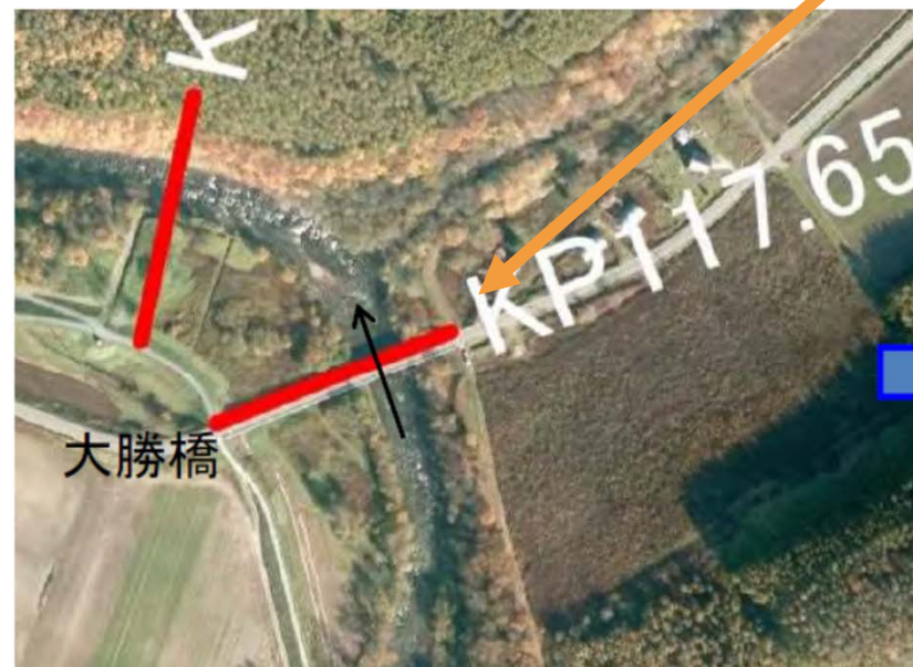
被災前の状況(流路が右岸寄り、H23撮影)
