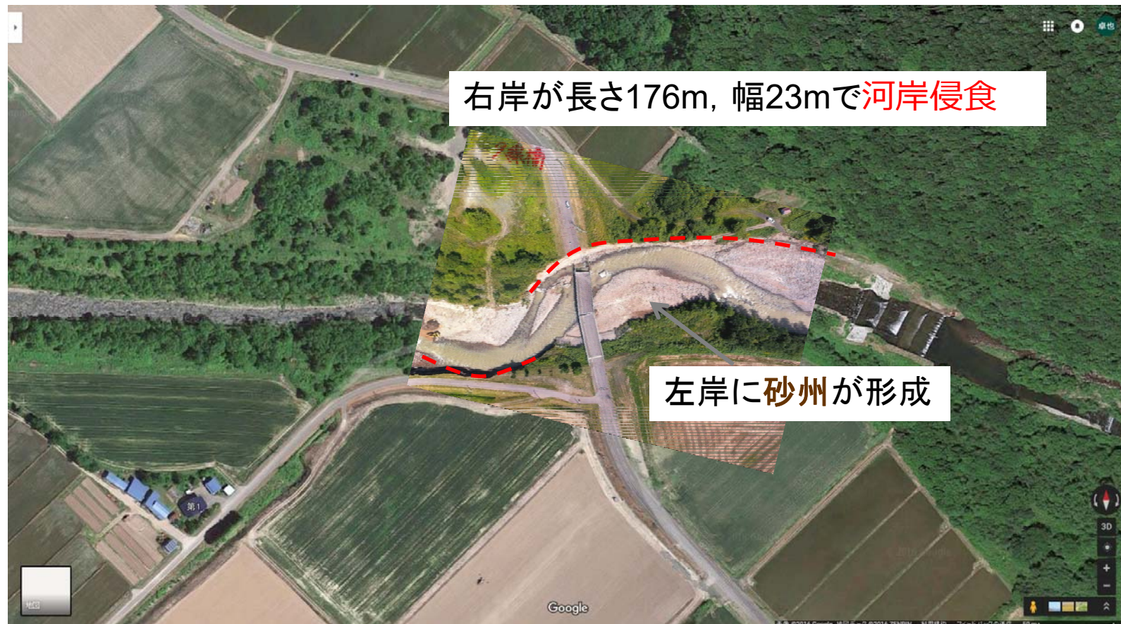
被災前の航空写真(Google)+UAV
