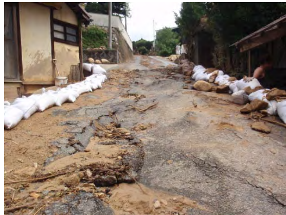
図 3-3-2-20 変形した道路（④付近）
