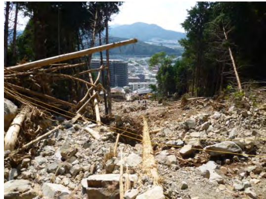
写真 3-3-5-6 下方分岐部の西側（土石流センサーが設置されている）
