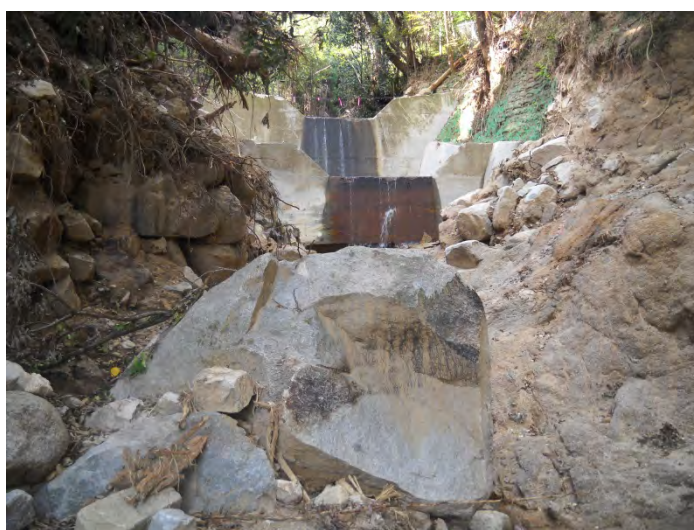
図 3-3-7-41 緑井八丁目の治山堰堤（2段式）
