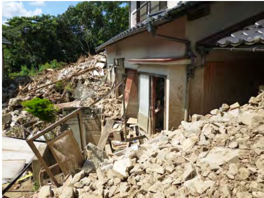
写真 3-3-5-65 東側の土石流が流入した最上部の家屋
