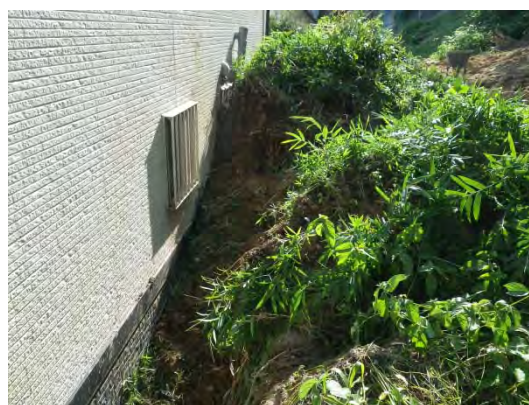
写真 3.3.8.1.13 坂道下部から崩壊した土砂の流下状況*)
