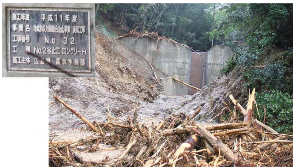
写真 3-4-8 安佐北区可部町下町屋土居の治山堰堤 (A-06-2 上流側) の前部の状況
