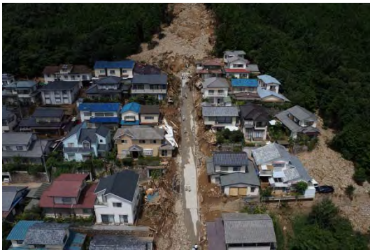
写真 3-3-5-47 東側と西側の土石流による被害状況(提供:ルーチェサーチ株)
