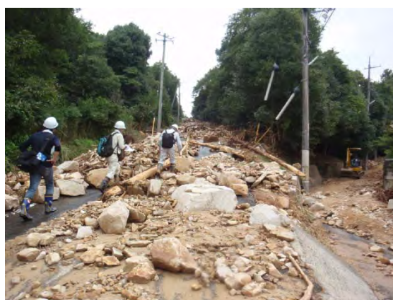
図 3-3-2-32 道路上に残留した流出土砂
