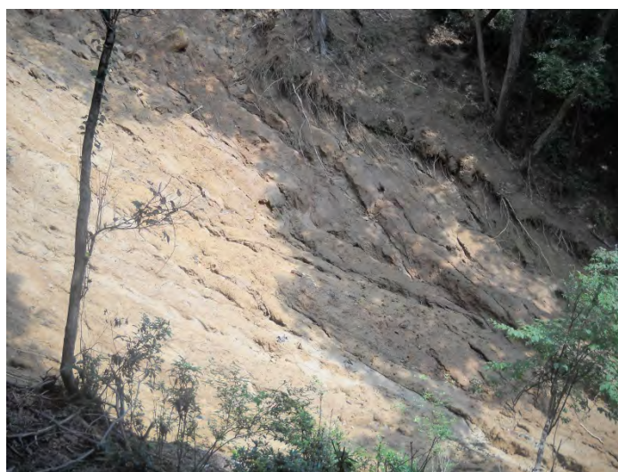
図 3-3-7-62 まさ土斜面ですべり面部の浸食が明瞭 (H 点)
