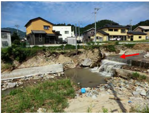
(b) 地点①での護岸の破壊
