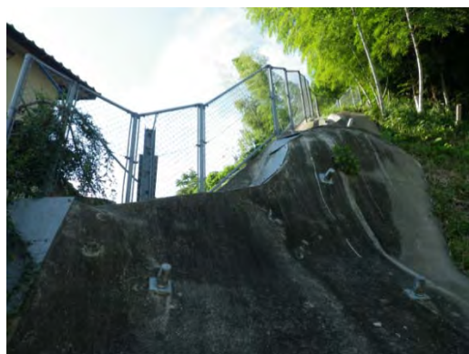
写真 3.3.8.1.19 崩壊部の西側の対策工*）
