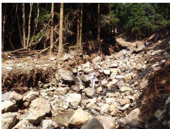
図 3-3-4-10 溪流合流部より約 20m 程度 下流付近
