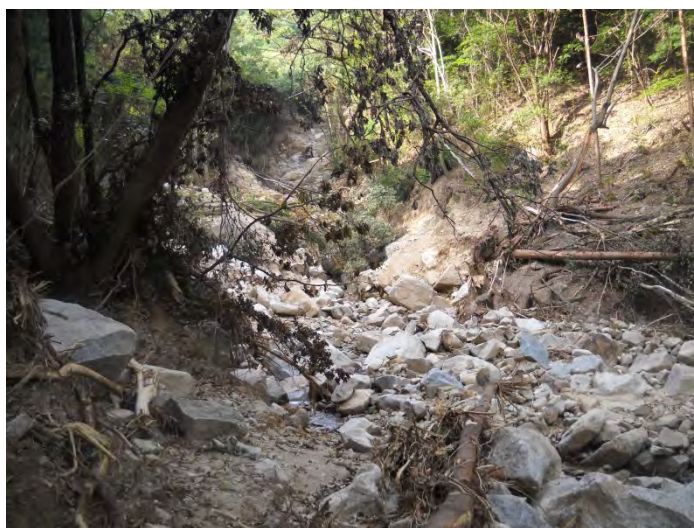
図 3-3-7-43 緑井八丁目の治山堰堤の上流側（その2）
