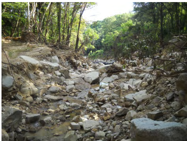
図 3-3-7-52 治山堰堤より下流を望む
