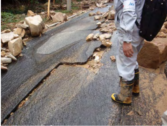
図 3-3-2-33 道路の陥没（位置は⑥）
