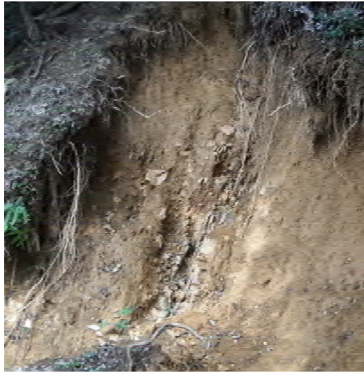
図 3-3-7-67 基岩の破碎帯からの被圧水の噴出によると思われる斜面崩壊
