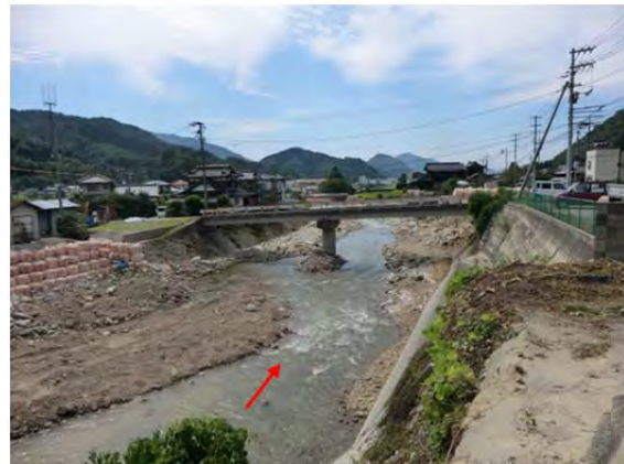
(d) 堰の下流部：護岸の破壊と側岸浸食
