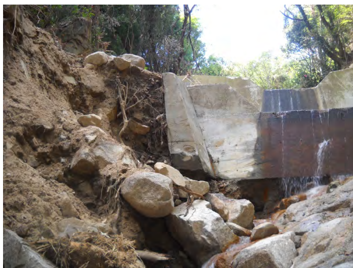
図 3-3-7-45 緑井八丁目の治山堰堤の下流側の洗掘（その 1）
