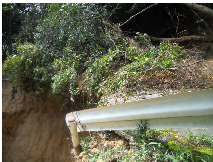
図 3-3-7-30 道路の路面の下は深く浸食されている（G点）
