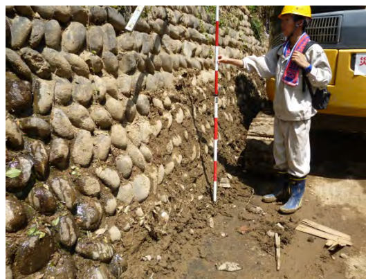
写真 3-3-5-64 横方向の道路に残る土砂堆積の痕跡
