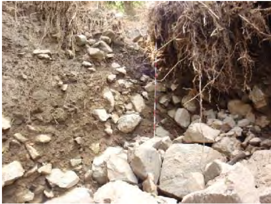
図 3-3-3-29 溪流上流端の高さ
