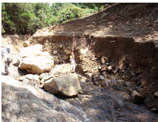
図 3-3-4-11 溪流合流部付近
