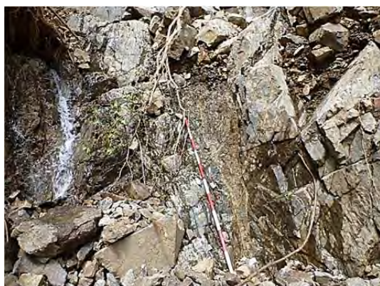
写真 3-3-5-43 変質部（断層露頭）
