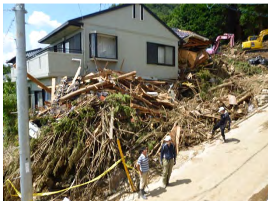
写真 3-3-5-61 団地中央の坂道の西側の住宅に流入した大量の土砂と流木
