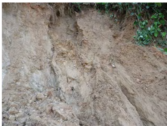
写真3.3.8.1.10 崩壊部の状況*)
