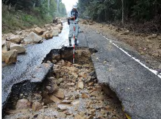
図 3-3-2-34 道路の陥没（位置は⑥）
