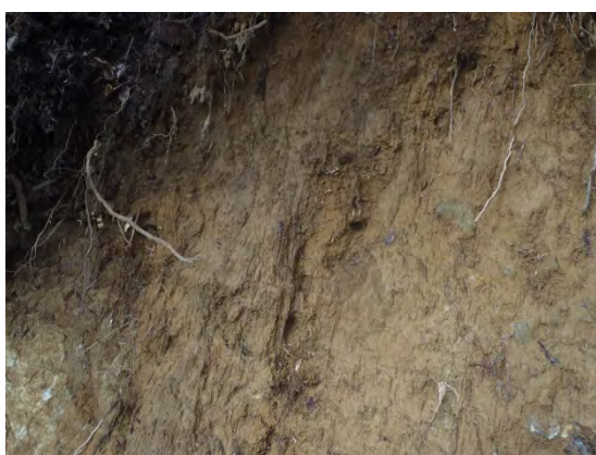
図 3-3-4-29 源頭部で見られたパイプフロー跡
