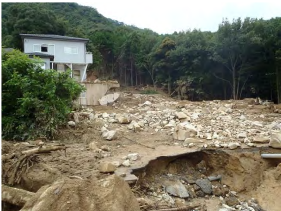
写真 3.3.6-3 土石流により家屋 3 軒が流失
