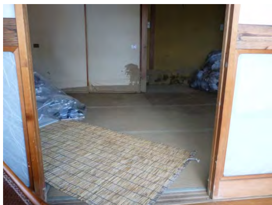
写真 3-3-5-63 屋内に侵入した土砂の痕跡
