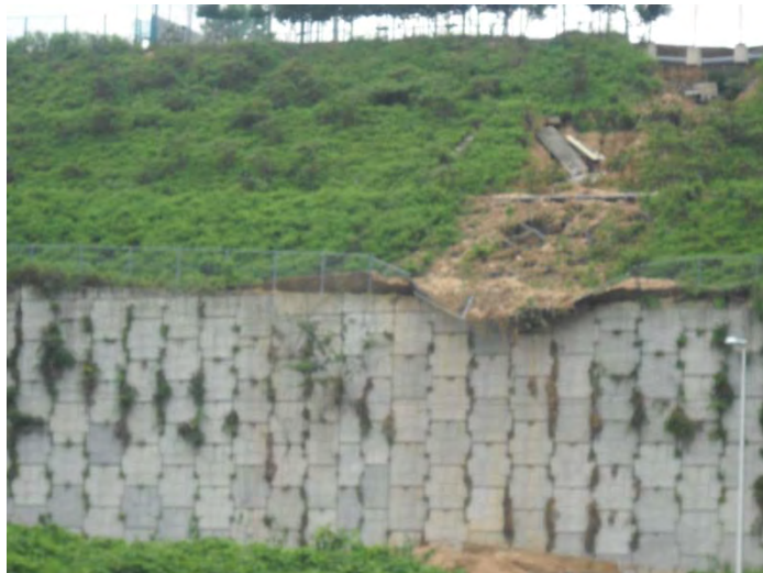
図 3. 3. 8. 2. 2 グラウンド法面の崩壊状況
