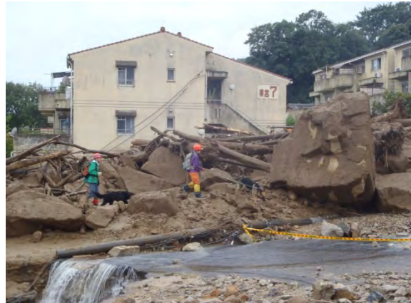
写真 3.3.6-32 7～9号棟の東側は道路や駐車 場となる
