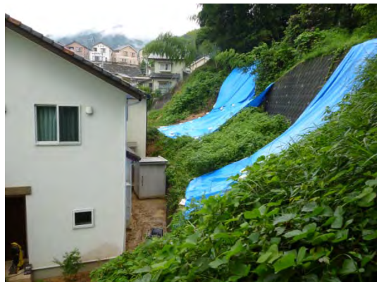
写真 3.3.8.1.2 山本八丁目の崩壊状況（東側から撮影）
