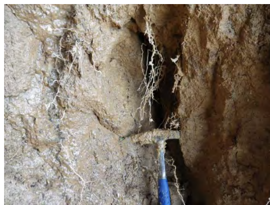
写真3.3.8.1.11 崩壊面の状況*)
