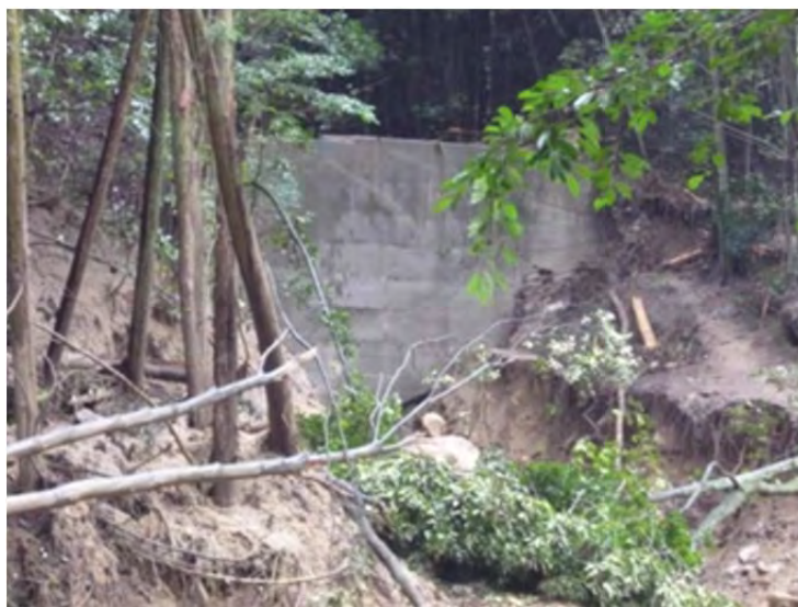
図 3-3-7-2 緑井七丁目の住宅地上流の治山ダム
