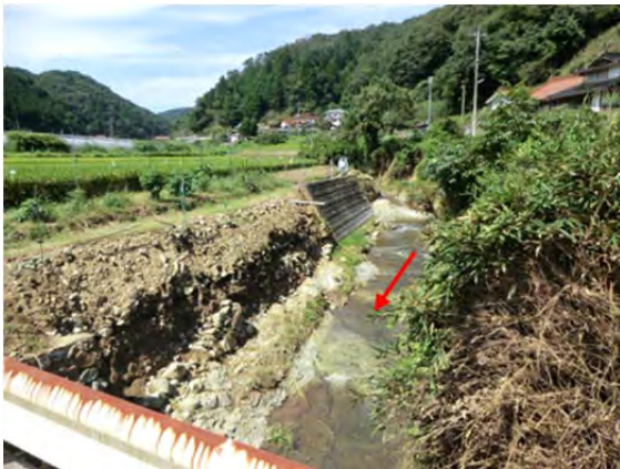
(d) 地点⑦での護岸の破壊
