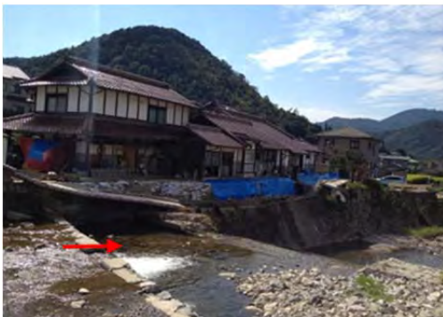
(d) 地点③での護岸の破壊
