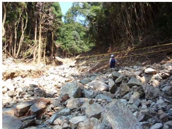
図 3-3-4-9 治山堰堤に堆積した礫
