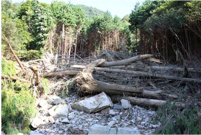
写真 3-4-15 治山堰堤（A-09）の下流側の状況
