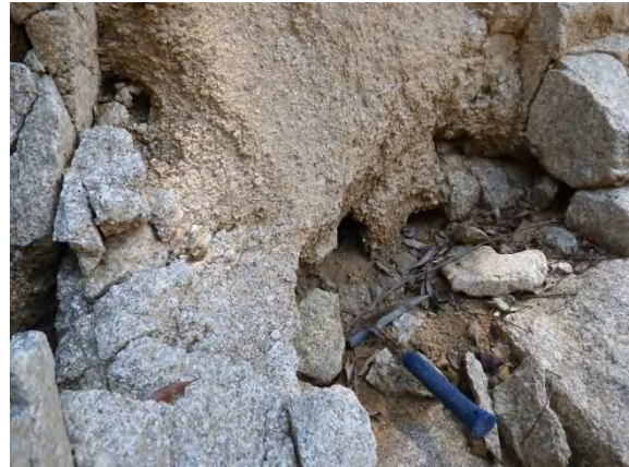
写真 3.3.6-14 基盤岩上面のパイプフローの痕跡
