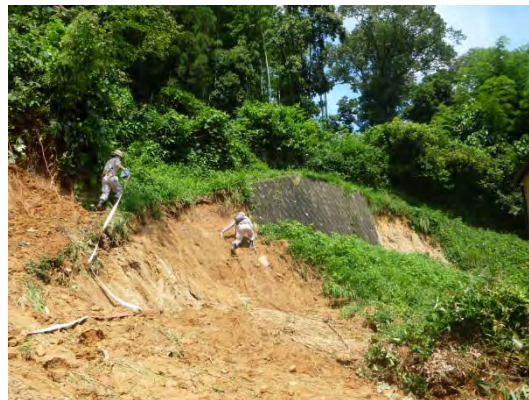
写真 3.3.8.1.3 山本八丁目の崩壊状況（西側から撮影）* )
