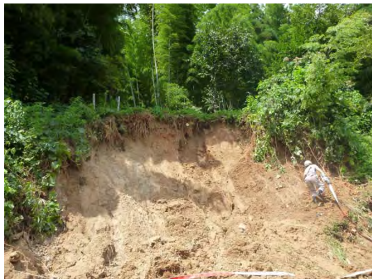
写真3.3.8.1.6 上部住宅跡地の法肩からの崩壊部*)
