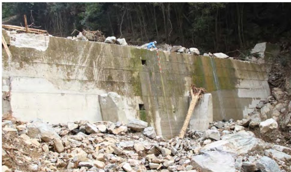
写真 3-4-4 安佐南区八木四丁目の堰堤の損壊状況
