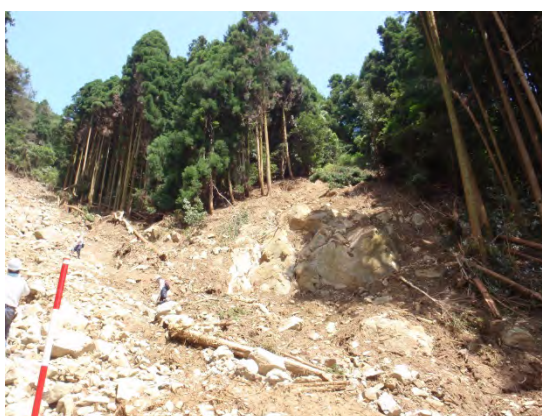
図 3-3-4-18 左岸側に見られて小規模崩壊
