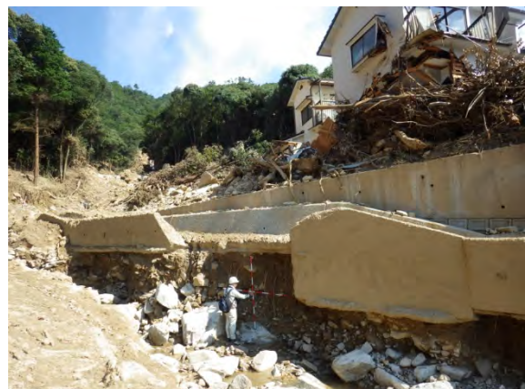
写真 3.3.6-28 第2波の堆積物の右岸側侵食 水路天端より4m程度
