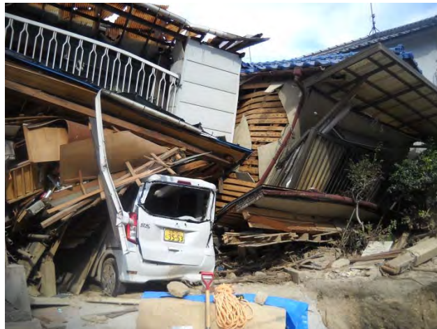
図 3-3-7-59 住宅地の被災状況（9月14日時点）（その5）
