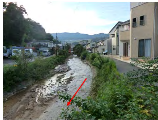
(d) 地点②での土砂堆積
