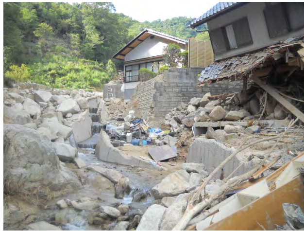
図 3-3-7-56 住宅地の被災状況（9月14日時点）（その2）
