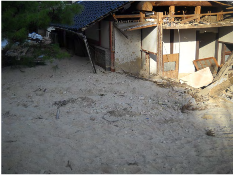
図 3-3-7-39 家屋背後に堆積した大量の土砂（その 2）
