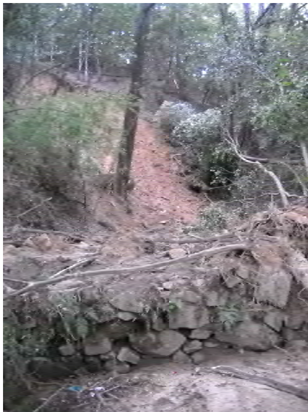
図 3-3-7-48 緑井八丁目の治山堰堤の下流側の石積み（その 2）
