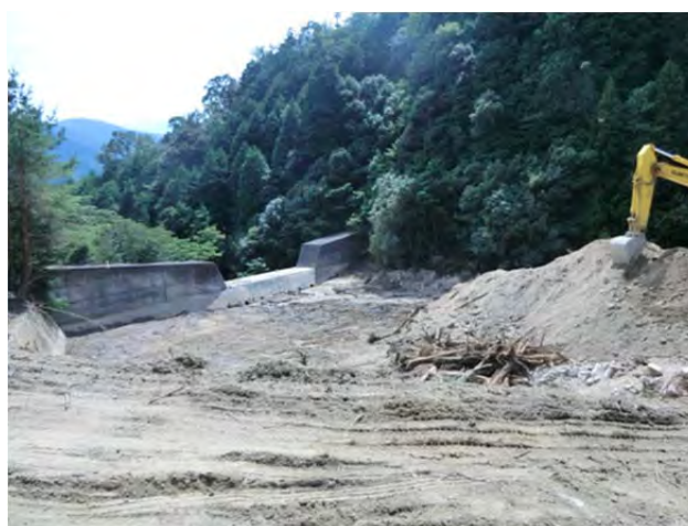
(c) 地点②の砂防堰堤での除石作業
