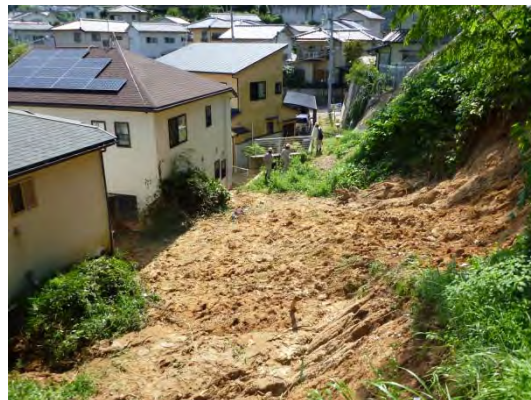
写真3.3.8.1.7 上部住宅跡地の法肩からの崩壊土砂の流下状況*)
