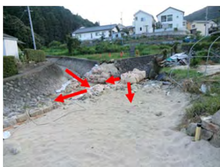
(d) 地点⑥での護岸の破損
