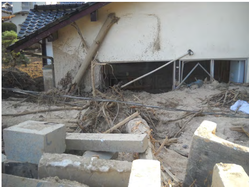
図 3-3-7-40 家屋内に流入した大量の土砂
