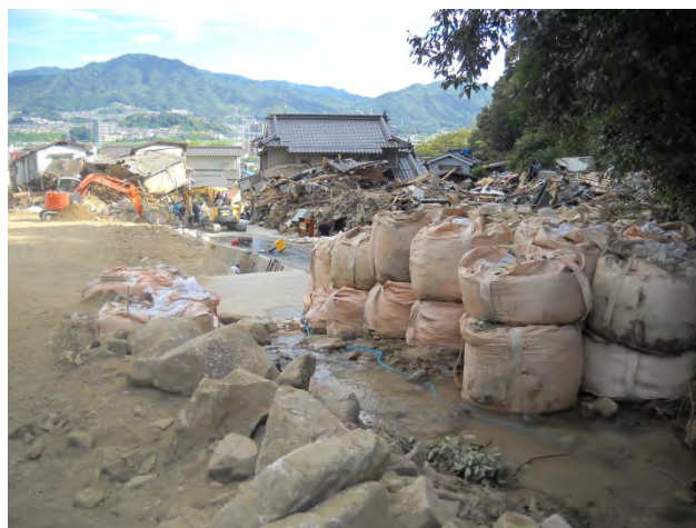
図 3-3-7-55 住宅地の被災状況（9月14日時点）（その1）
