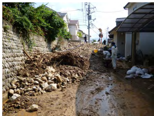
写真 3-3-5-70 団地の西側の坂道下部にある横方向道路の堆積状況（写真3-3-5-69の奥を西側から撮影）
