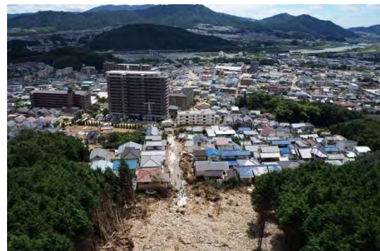
写真 3-3-5-50 上流から見た西側土石流による被害状況(提供:ルーチェサーチ株)
