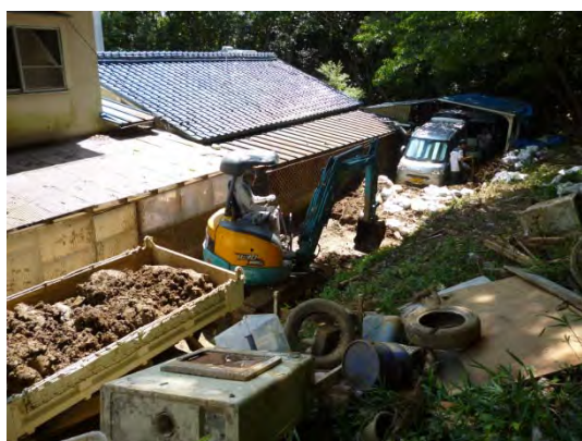
写真 3-3-5-59 団地の西側から流入した土石流によって堆積した土砂（団地西側の最上段の道路）
