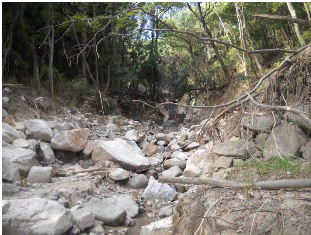
図 3-3-7-51 治山堰堤より下流の状況
