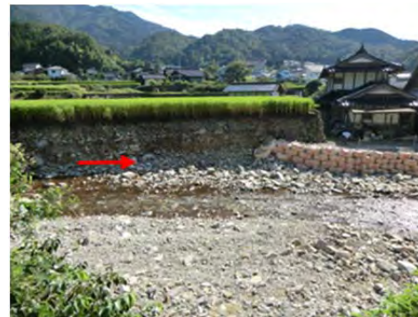
(e) 地点④での護岸の破壊
