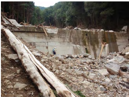
図 3-3-4-8 被災した治山堰堤の様子
