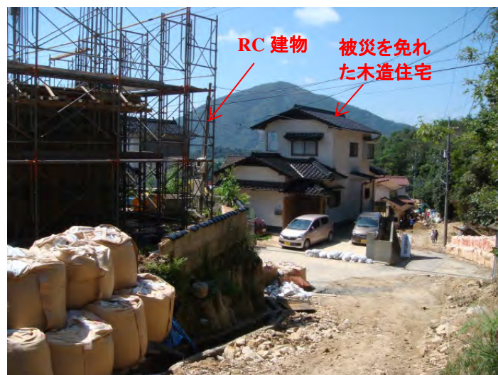
図 3-3-2-39 RC 建物の背後の木造住宅（位置は⑧）
