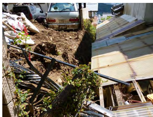
写真 3-3-5-60 団地最上段の下側の住宅への土砂の流入状況
