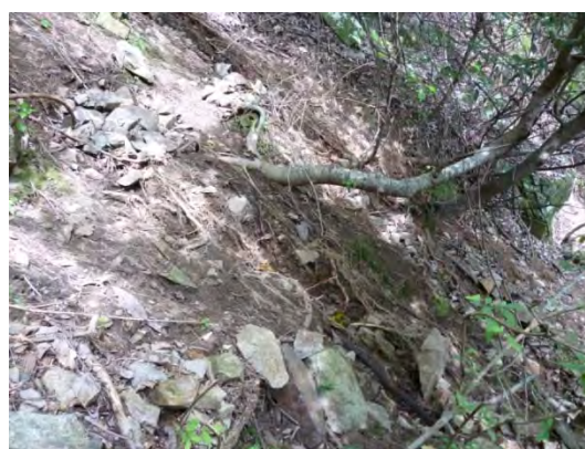
写真 3-3-5-36 地表水によって洗掘された斜面
