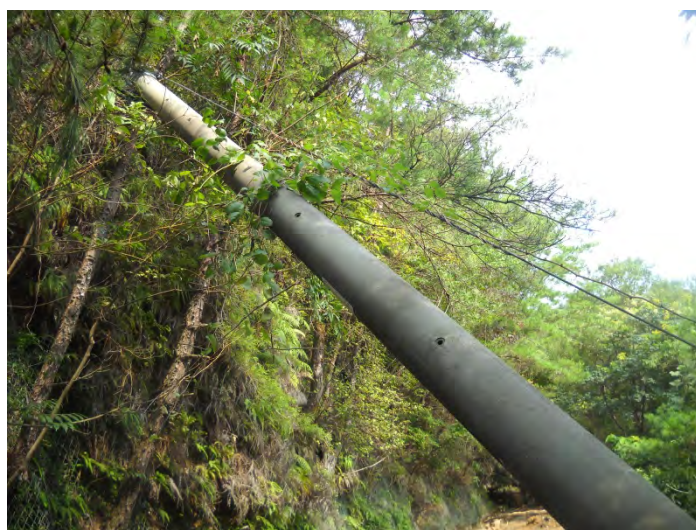
図 3-3-7-21 土石流で引っ張られた電柱（D点の手前）
