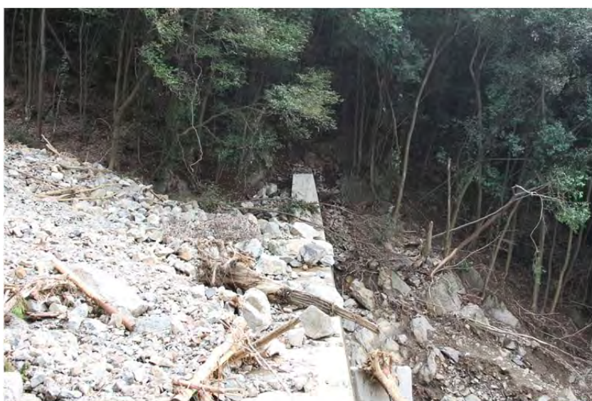
写真 3-4-5 安佐南区八木四丁目の堰堤の堆砂状況
