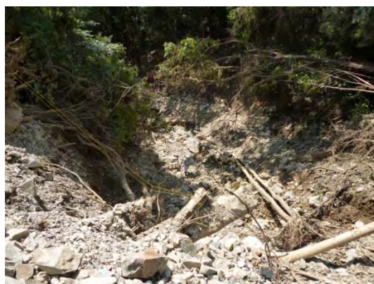
写真 3-3-5-12 上方分岐部の西側土石流(土石流センサーが設置)
