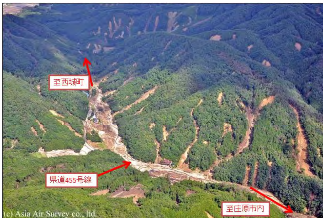
図 4-3-6 篠堂地域の斜面崩壊の状況（北東方向を撮影, アジア航測(株)提供）
