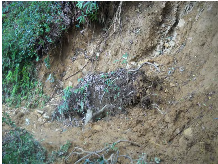
図 3-3-7-68 破碎帯からの崩壊が土石流へ
