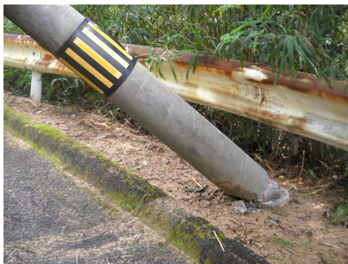
図 3-3-7-22 電柱の根元の等間隔クラック（D点の手前）
