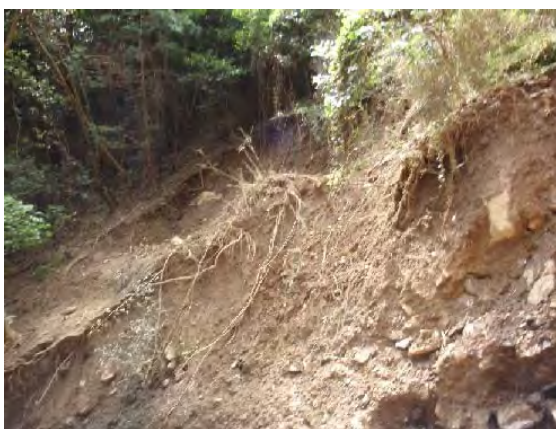
図 3-3-3-25 溪流右岸の小規模崩壊
