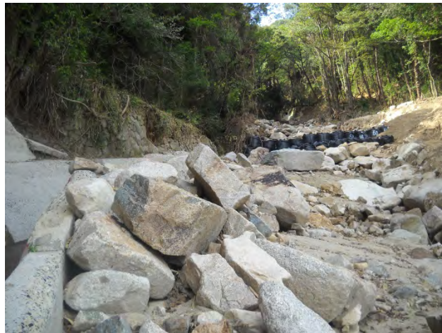
図 3-3-7-53 流路工（左端）の横をえぐるように土石流は流下
