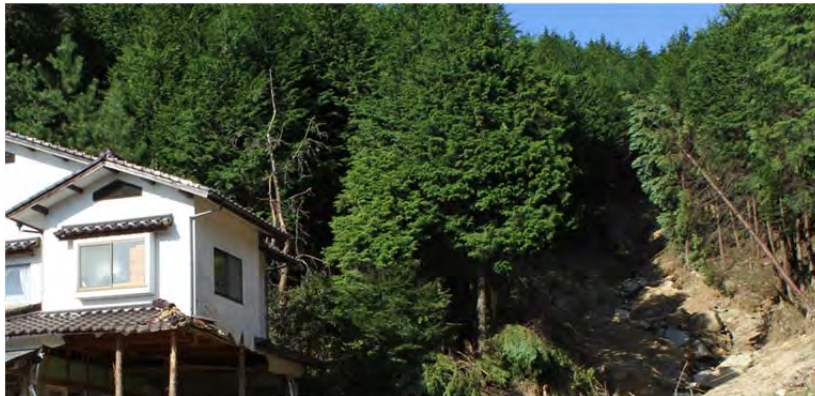
写真 3-4-13 安佐北区可部町上原の堰堤設置溪流に隣接する谷部で土石流が発生した。
