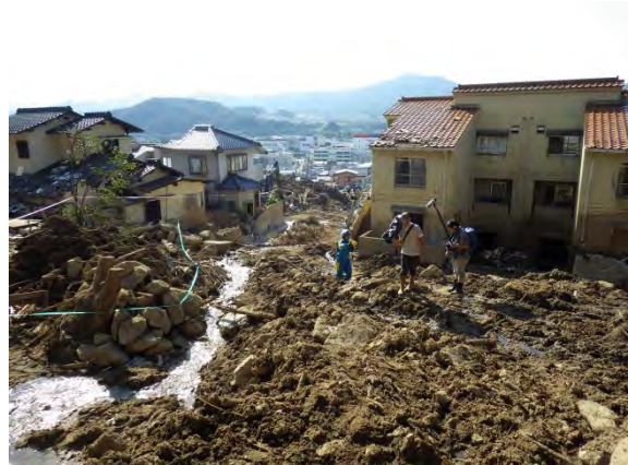
写真 3.3.6-30 氾濫開始点③から下流を展望 9号棟の東側に氾濫
