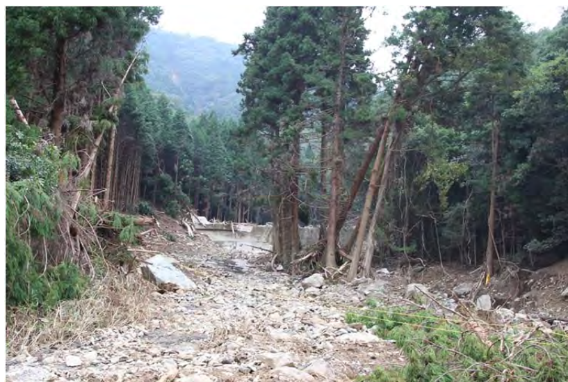
写真 3-4-6 安佐南区八木四丁目の堰堤下流側の状況
