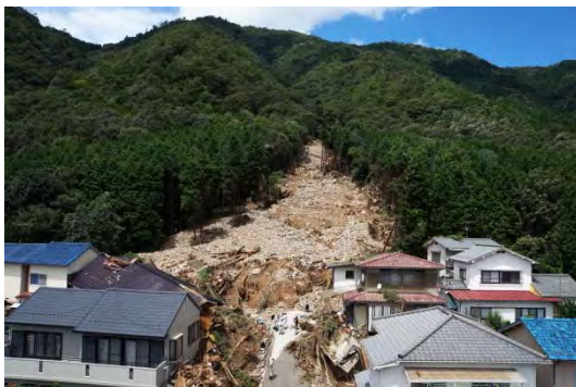
写真 3-3-5-49 西側の土石流による被害状況(提供:ルーチェサーチ株)
