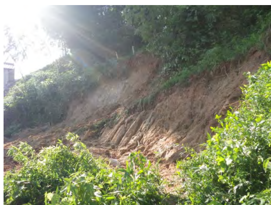
写真 3.3.8.1.12 上部住宅跡へ上がる坂道の下部からの崩壊*)
