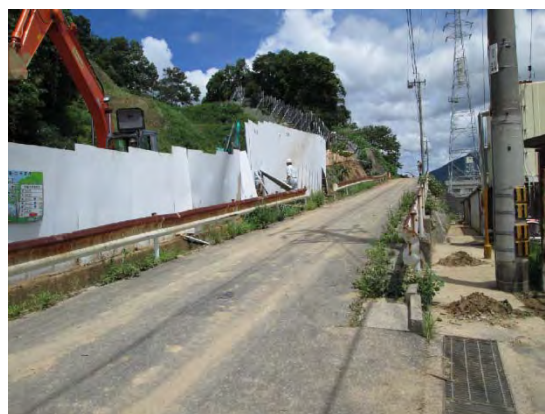
図 3-3-3-53 崖崩れ付近の道路
