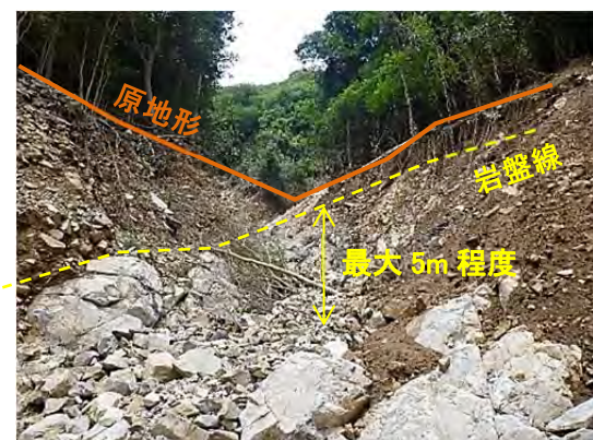
写真 3-3-5-46 土石流でえぐられた岩盤深度（推定）
