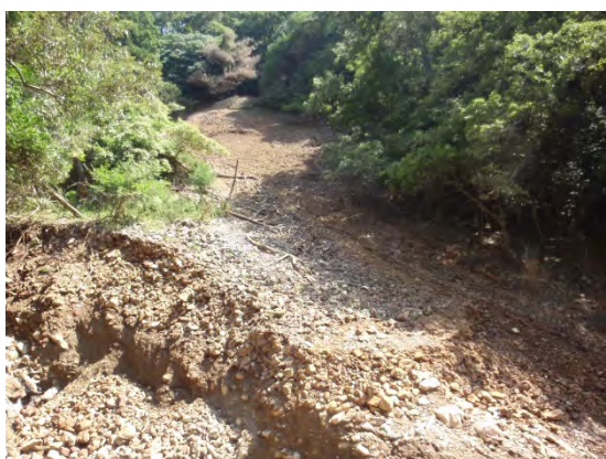
図 3-3-4-12 左岸側の土石流の様子
