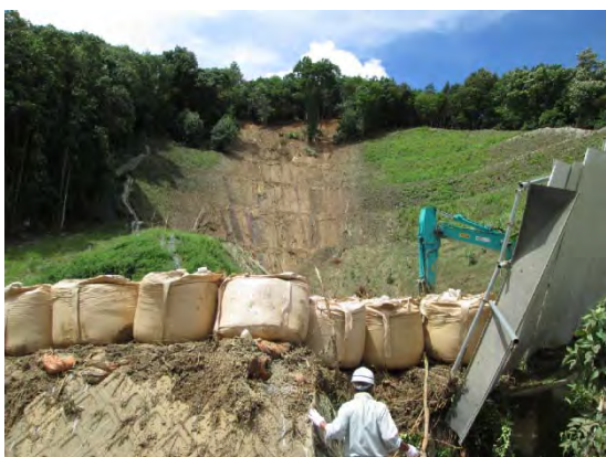
図 3-3-3-52 崖崩れ (8月21日撮影)
