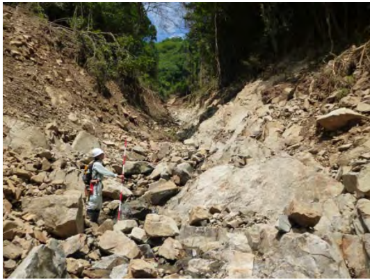
写真 3-3-5-20 東側（本流）の土石流
