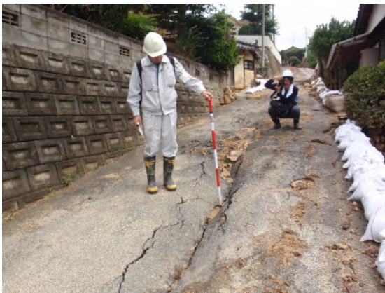
図 3-3-2-19 変形した道路（④付近）
