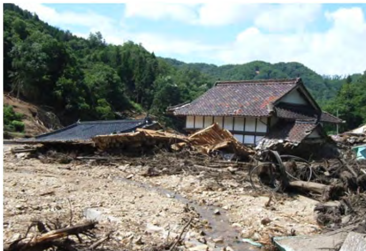
図 4-3-8 篠堂川右岸で発生した土石流による家屋の被害（広島県提供）
