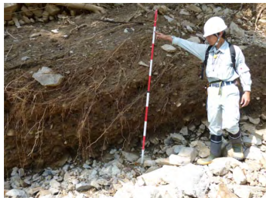
写真 3-3-5-8 下方分岐部左岸の状況
