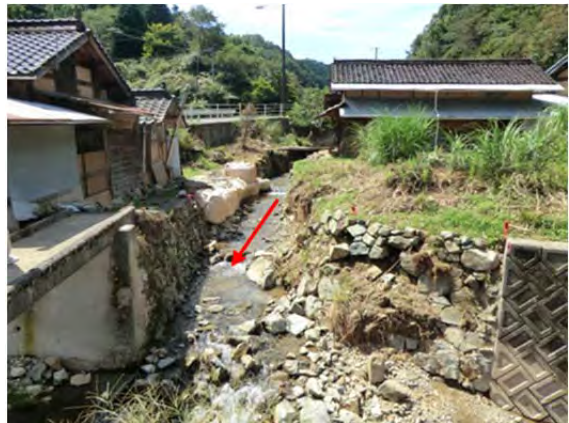
(e) 地点⑧での護岸の破壊
