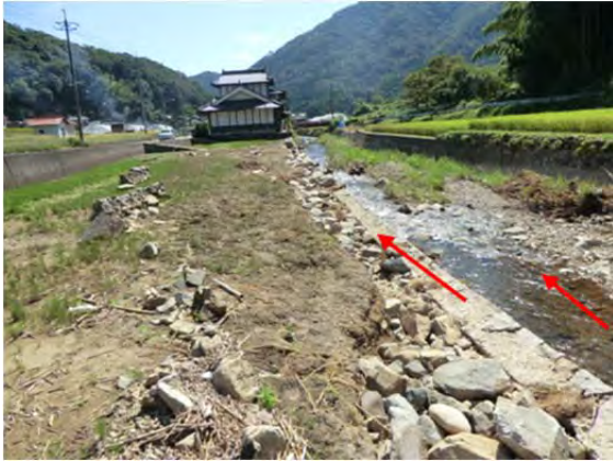
(b) 地点⑤での護岸の破壊と溢水
