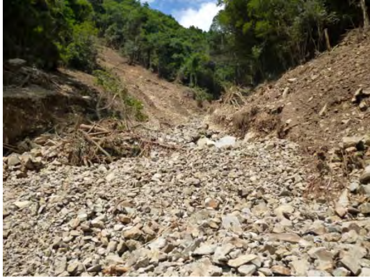
写真 3-3-5-18 西側からの合流部①
