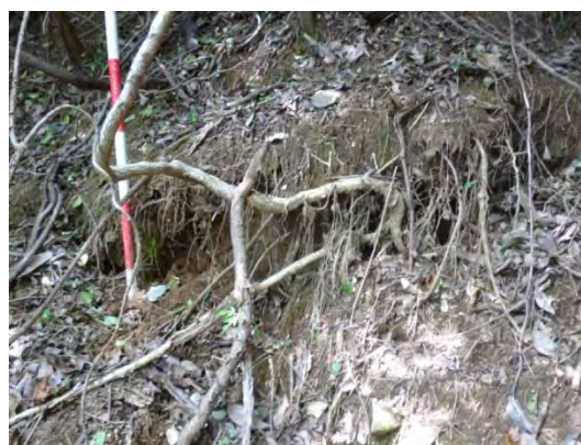
写真 3-3-5-34 斜面崩壊上部の地山で見られた段差
