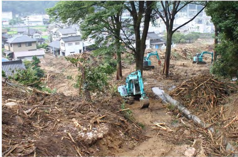
写真 3-4-9 安佐北区可部町下町屋土居の治山堰堤の下流域の状況
