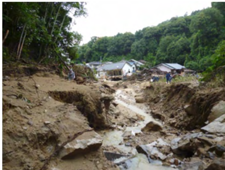
図 3-3-7-5 緑井七丁目の住宅地出口付近
