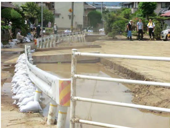
図 3-2-19 八木用水での土砂堆積状況 (8月23日撮影)
