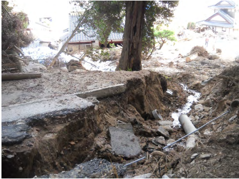
図 3-3-7-37 神社の境内の土石流の洗掘
