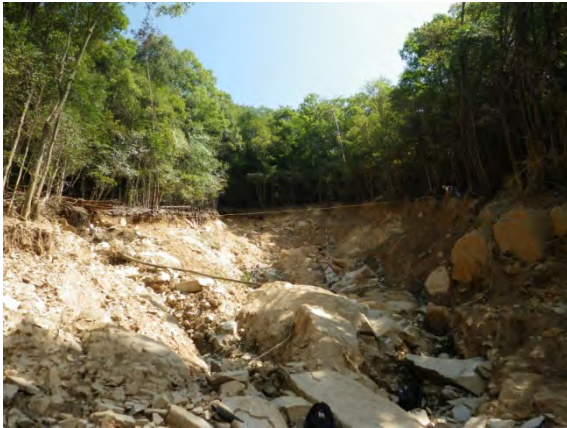
写真 3.3.6-13 支流①の源頭部の崩壊, 幅 20m で 4~5m 以上の深さに及ぶ
