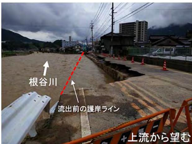
(c) 地点①での護岸の破壊
