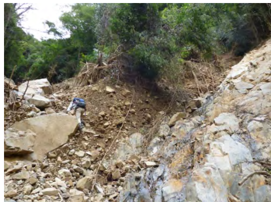
写真 3-3-5-22 東側の土石流
