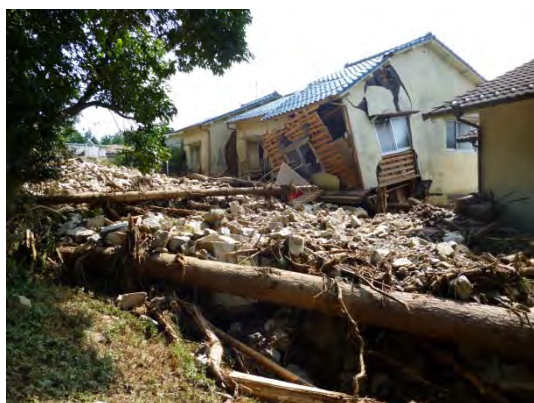
写真 3-3-5-57 団地中央部の最上部での土砂の堆積状況（写真の上方が東方向）
