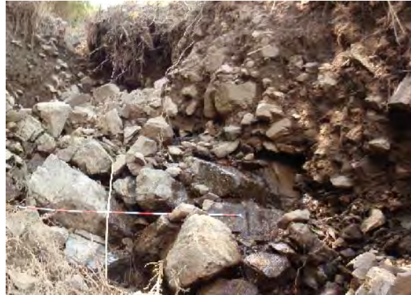
図 3-3-3-30 溪流上流端からの水の滲出
