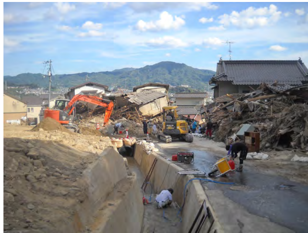
図 3-3-7-57 住宅地の被災状況（9月14日時点）（その3）
