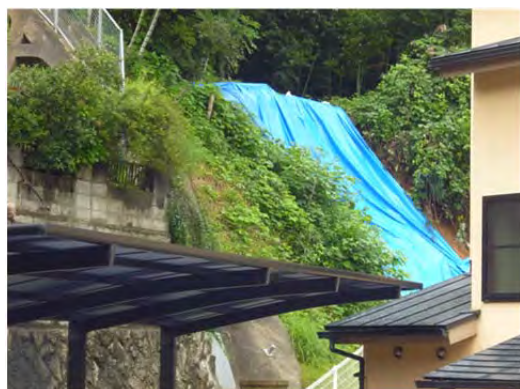
写真 3.3.8.1.18 西側崩壊部の周辺
