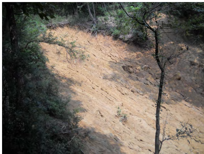
図 3-3-7-61 緑井八丁目の土石流の源頭部の一つ (H 点)
