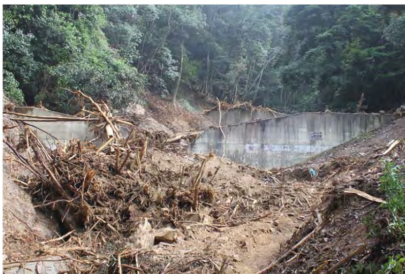
写真 3-4-7 安佐北区可部町下町屋土居の治山堰堤 (A-06-1 下流側) の前部の状況
