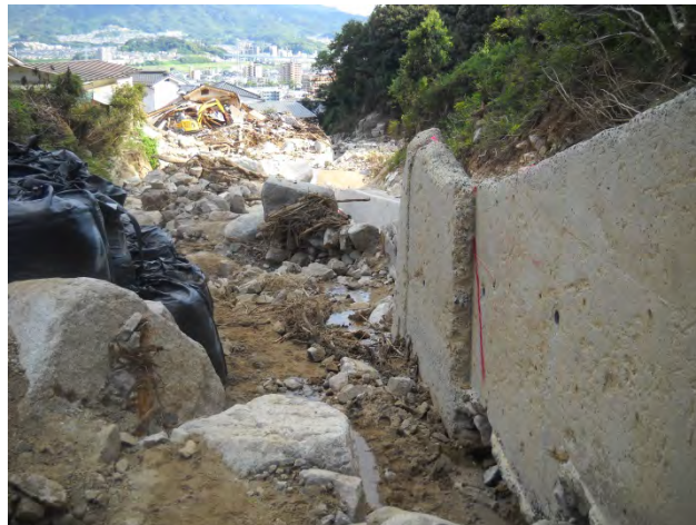
図 3-3-7-54 流路工（右端）の下端近くまで洗掘
