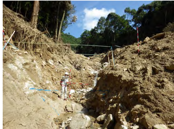
写真 3.3.6-26 写真 3.3.6-25 の右岸側の侵食 ポールは左写真に写るもの
