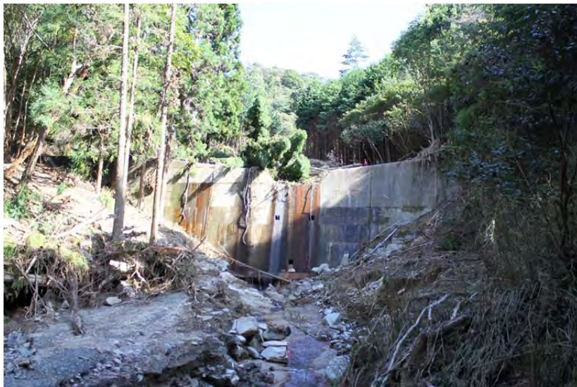
写真 3-4-14 治山堰堤 (A-09) 前部の状況
