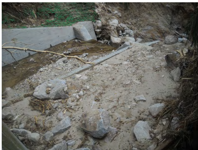
図 3-3-7-44 緑井八丁目の治山堰堤（下流側）
