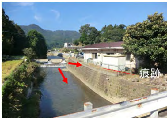
(b) 地点①での溢水の痕跡
