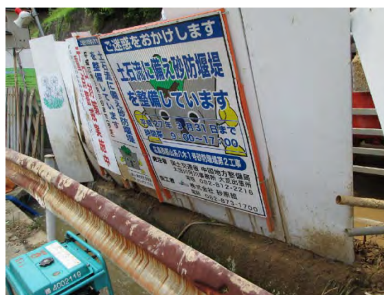
図 3-3-3-54 壊れたフェンス
