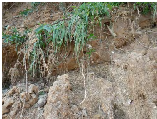
写真 3.3.8.1.14 坂道下部の崩壊部*)
