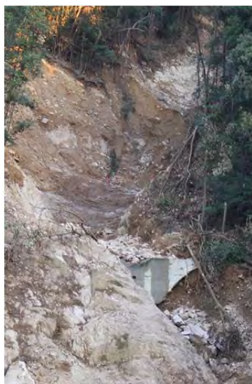
写真 3-4-10 堰堤前面の埋戻し土も流出している
