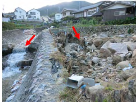
(e) 護岸の背面での洗掘
