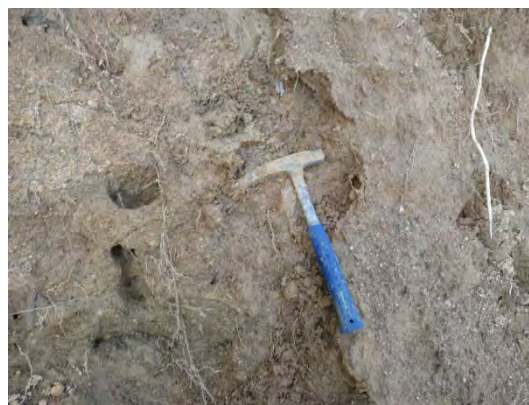
写真 3.3.8.1.15 坂道下部の崩壊部に見られる地下水の噴出跡*)
