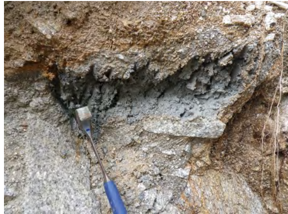
写真 3.3.6-8 常時地下水面下にあったものと考えられる灰色の砂質土
