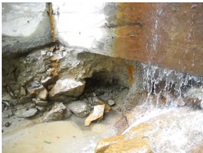
図 3-3-7-46 緑井八丁目の治山堰堤の下流側の洗掘（その 2）
