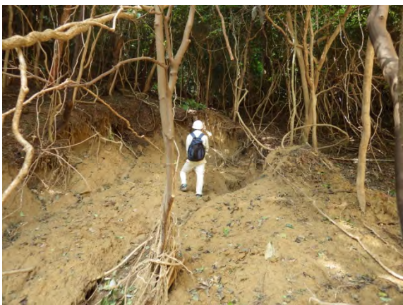
写真 3.3.6-9 緩勾配のまさ土斜面の崩壊
