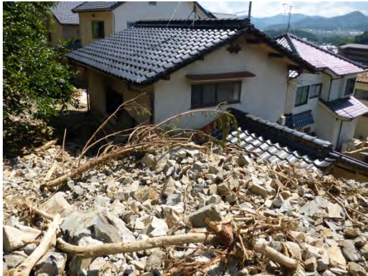
写真 3-3-5-51 東側の土石流が直撃した家屋
