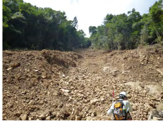
写真 3-3-5-19 西側からの土石流
