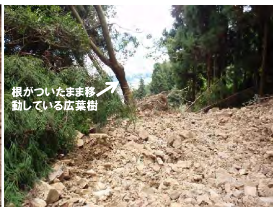
図 3-3-3-36 最上流の崩壊場所から 下流側を眺めたところ
