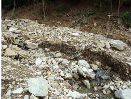
図 3-3-4-6 削れられた溪流側面
