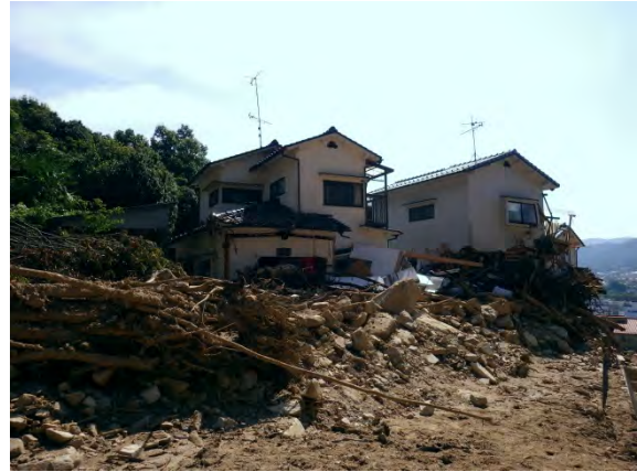
写真 3.3.6-24 第1波による堆積の下端 最上流の家屋が被災(流失なし)
