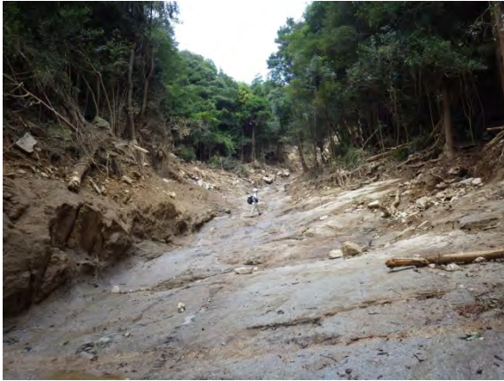
写真 3.3.6-11 堆積物,風化帯,軟岩が削られ, 溪床は 10~15m 幅で露岩する
