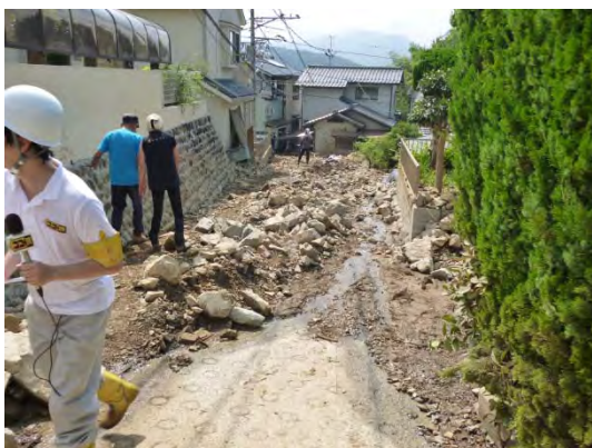
写真 3-3-5-69 団地の西側の坂道下部での土砂の堆積状況（上側から撮影）
