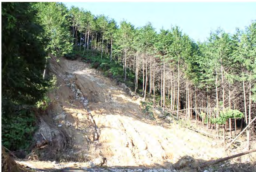
写真 3-4-12 安佐北区可部町上原 (A-08) の堰堤背後の斜面で生じた表層崩壊
