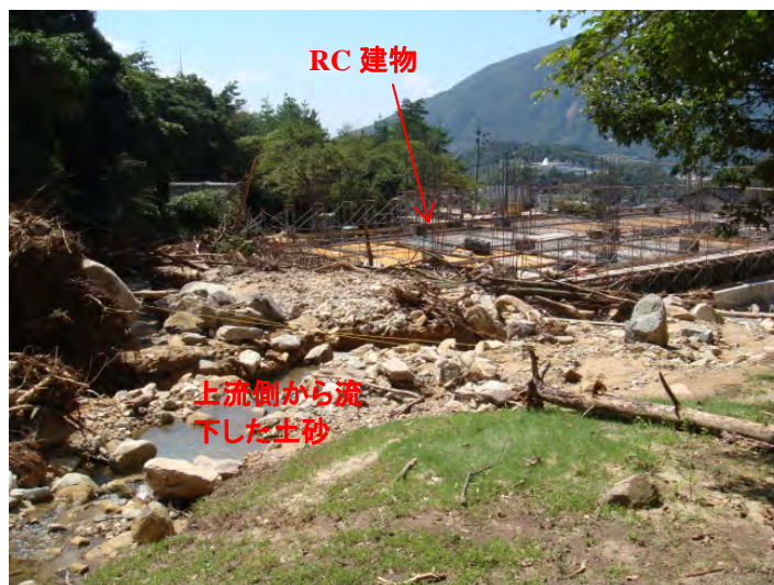
図 3-3-2-38 建築中の RC 建物が土石流をせき止めた事例（位置は⑧）
