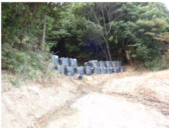
図 3-3-3-41 八木六丁目の土石流出口 応急対策済み
