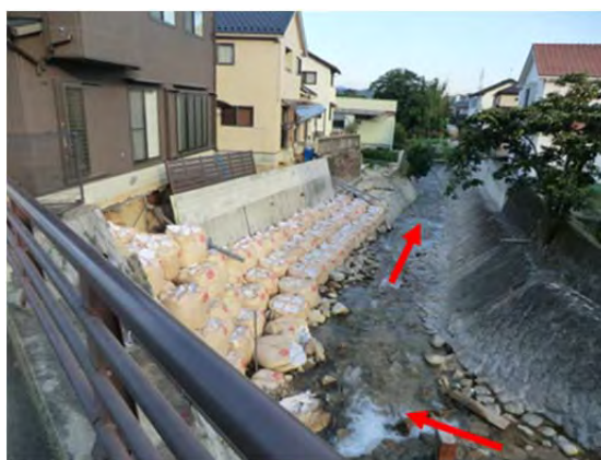
(b) 地点④での護岸の被災
