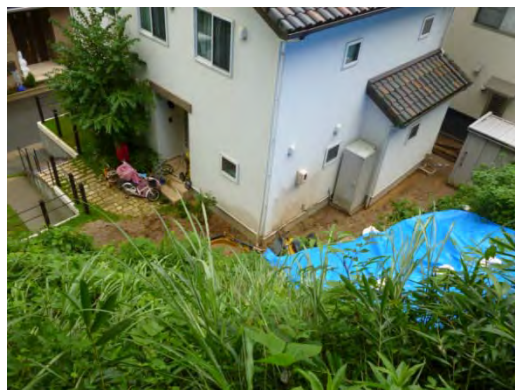
写真 3.3.8.1.17 東側崩壊土砂の流下状況
