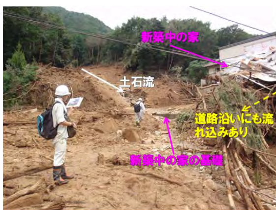
図 3-3-2-21 土石流で新築中の家が移動（⑤）
