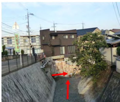
(b) 地点④での護岸の被災
