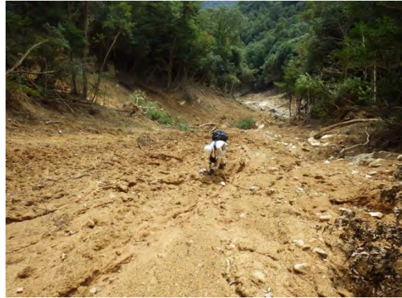
写真 3.3.6-6 崩壊後10日経過した8月31日時点でもぬかるんでいる
