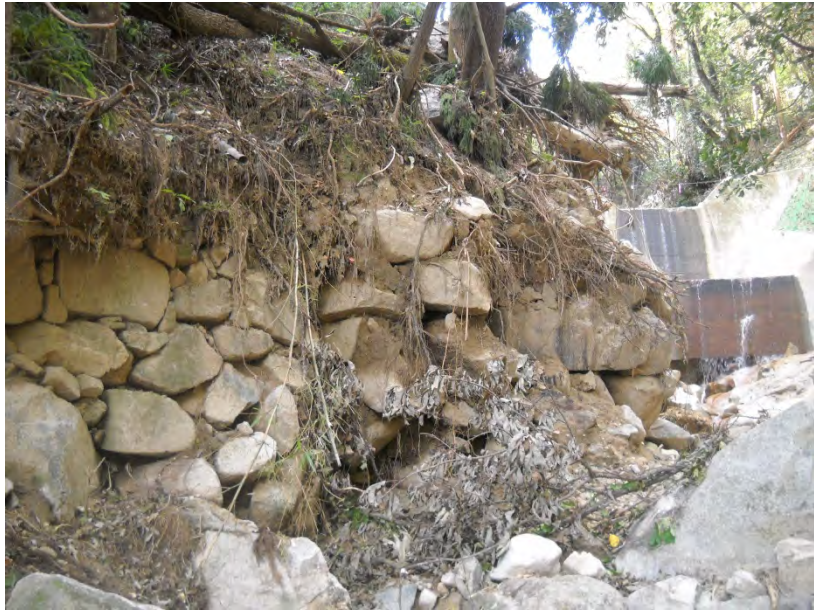
図 3-3-7-47 緑井八丁目の治山堰堤の下流側の石積み（その 1）
