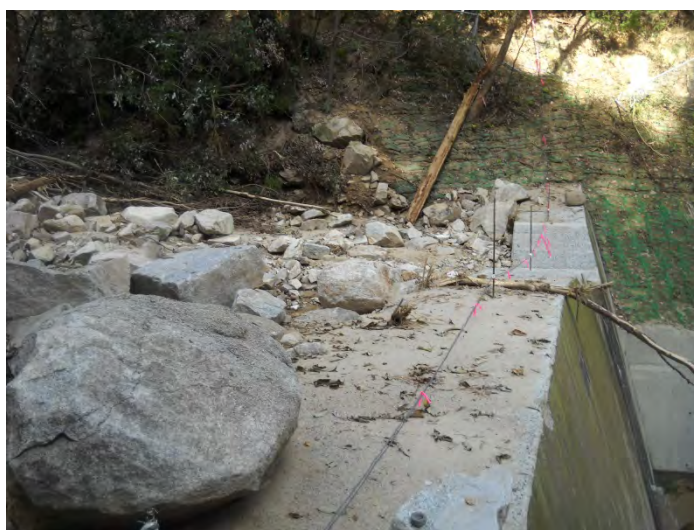
図 3-3-7-42 緑井八丁目の治山堰堤の上流側（その1）
