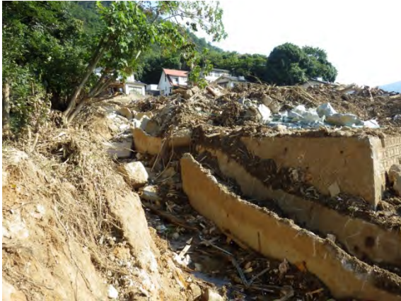
写真 3.3.6-29 氾濫開始点③付近 県営緑丘住宅9号棟の上流
