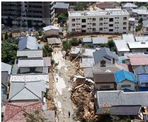
写真 3-3-5-67 団地中央の坂道の直下にあるアパートと住宅への土石流の流入状況（提供：ルーチェサーチ株）
