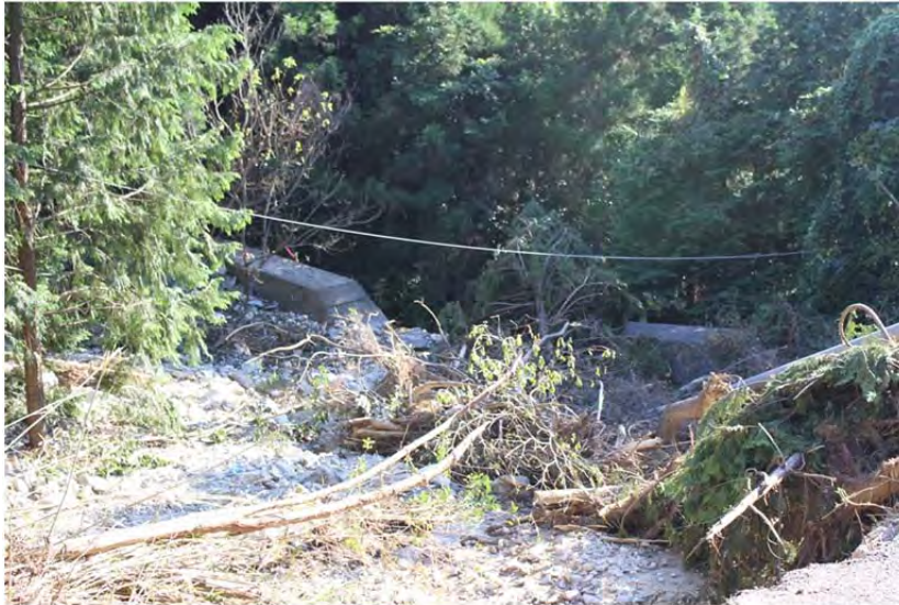
写真 3-4-11 安佐北区可部町上原 (A-08) の堰堤の堆砂の状況
