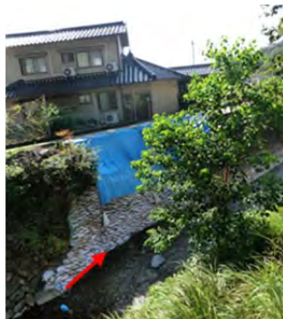
(d) 地点③での護岸の破壊
