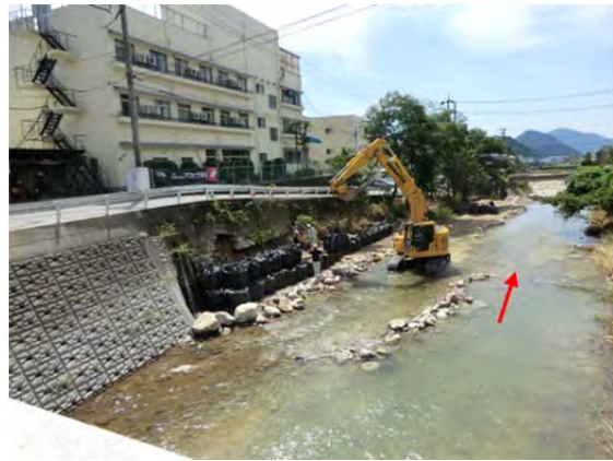
(b) 堰の上流部：護岸の破壊と側岸浸食
