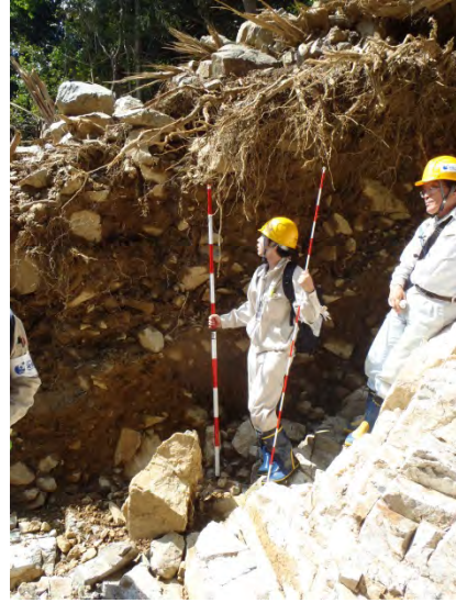
図 3-3-4-15 合流部上流側の様子
