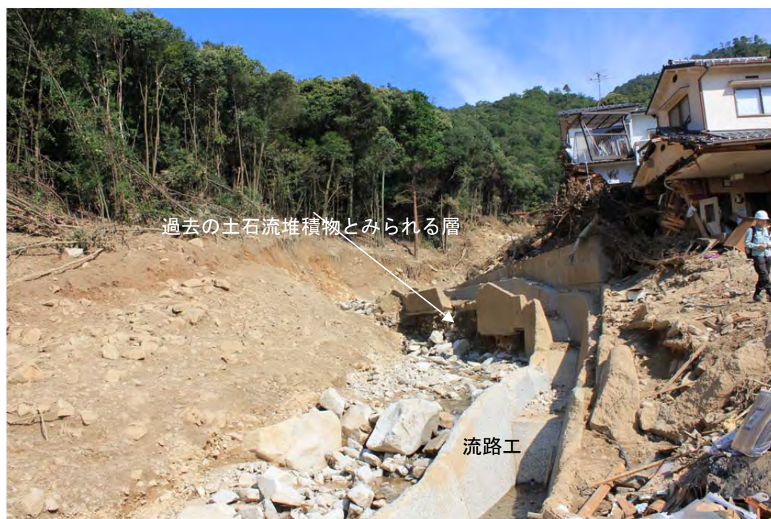
図 4-2-14 県営緑ヶ丘住宅裏の溪流における土石流堆積物の状況
