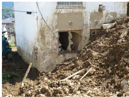
写真 3-3-5-68 団地中央の坂道の直下にあるアパートの被災状況
