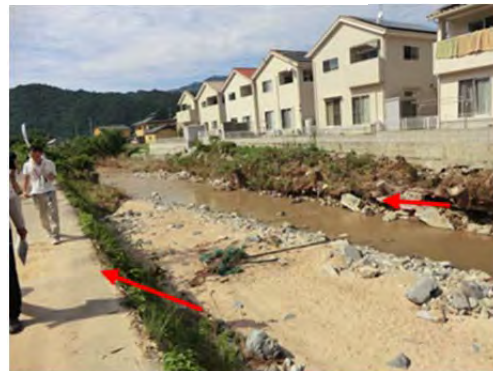
(c) 地点②での護岸の破壊と溢水
