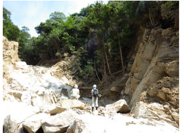
写真 3.3.6-20 滝下流の左岸側では高さ 10m 付近まで土石流痕が見られる
