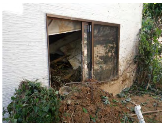
写真3.3.8.1.9 被災家屋の状態（1階の奥側）*)
