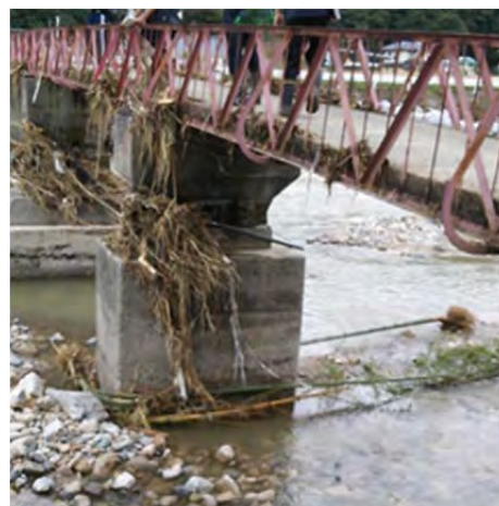
(d) 下流の橋梁に残る洪水痕跡
