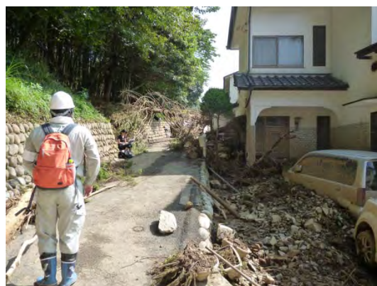
写真 3-3-5-58 団地最上部の道路（写真 3-3-5-57 の西側）
