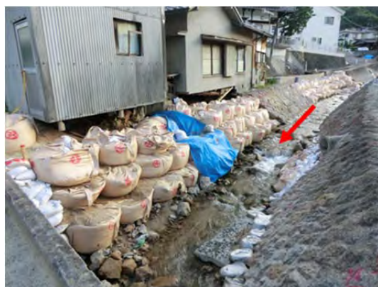
(b) 地点④での護岸の被災
