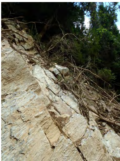
図 3-3-4-25 地点 H 付近の岩盤の様子
