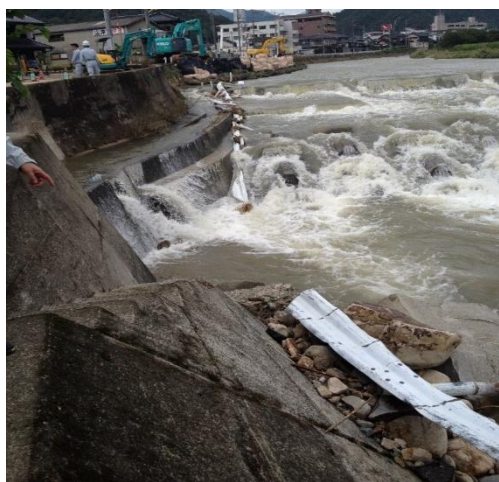
図3-6 法面の崩落
