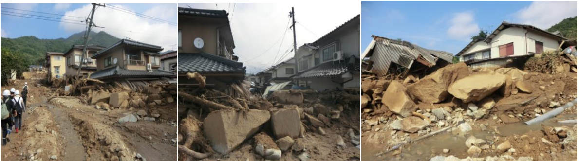
図4-5 巨岩に押しつぶされた家
