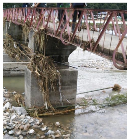
図3-7 橋梁に掛かる樹木
