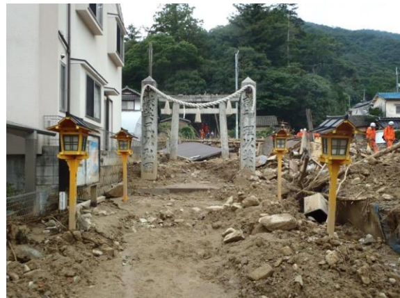
図4-10 光廣神社での土砂の堆積状況
