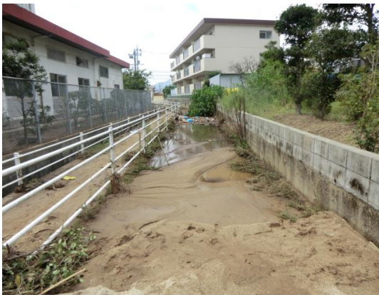
図4-11 土砂の堆積した水路
