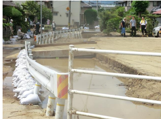
図4-11 土砂の堆積した水路
