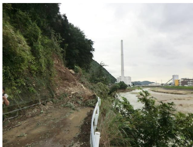
図 3-4 土砂崩れによる道路の封鎖と護岸の損傷
