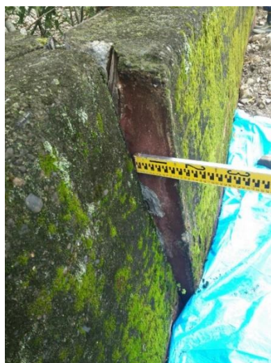
図3-2 護岸ブロック上武の川側への移動 護岸の前面は埋め戻しされ、ブルーシートで覆われていた。
