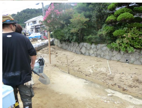
図 4-13 土砂による水路の閉塞状況
