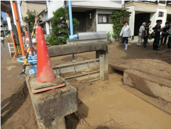
図4-3 土砂で埋まる用水路
