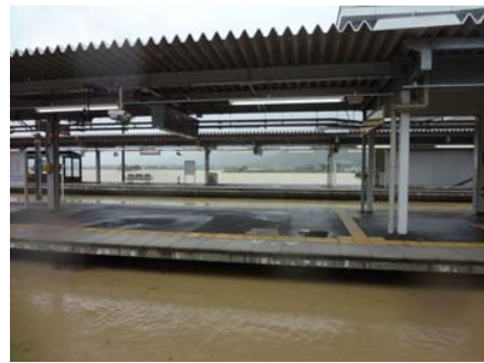
写真-1 JR亀岡駅プラットホームを南側から望む
