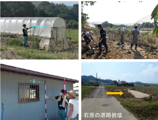
図-6 土・川北地区周辺の浸水痕跡と農地の被害(9/23)
