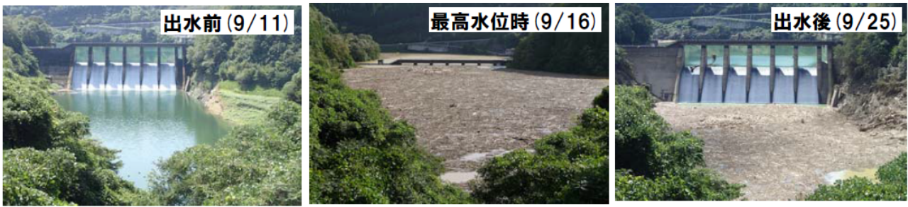
写真-9 洪水前後の日吉ダム貯水池内（世木ダム下流）の流木集積状況（独）水資源機構提供
