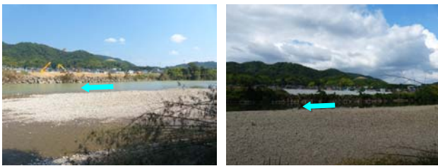
図-26 私市地区の堤防緊急復旧工事 (2013/9/23) と現在の様子 (2014/6/6)
