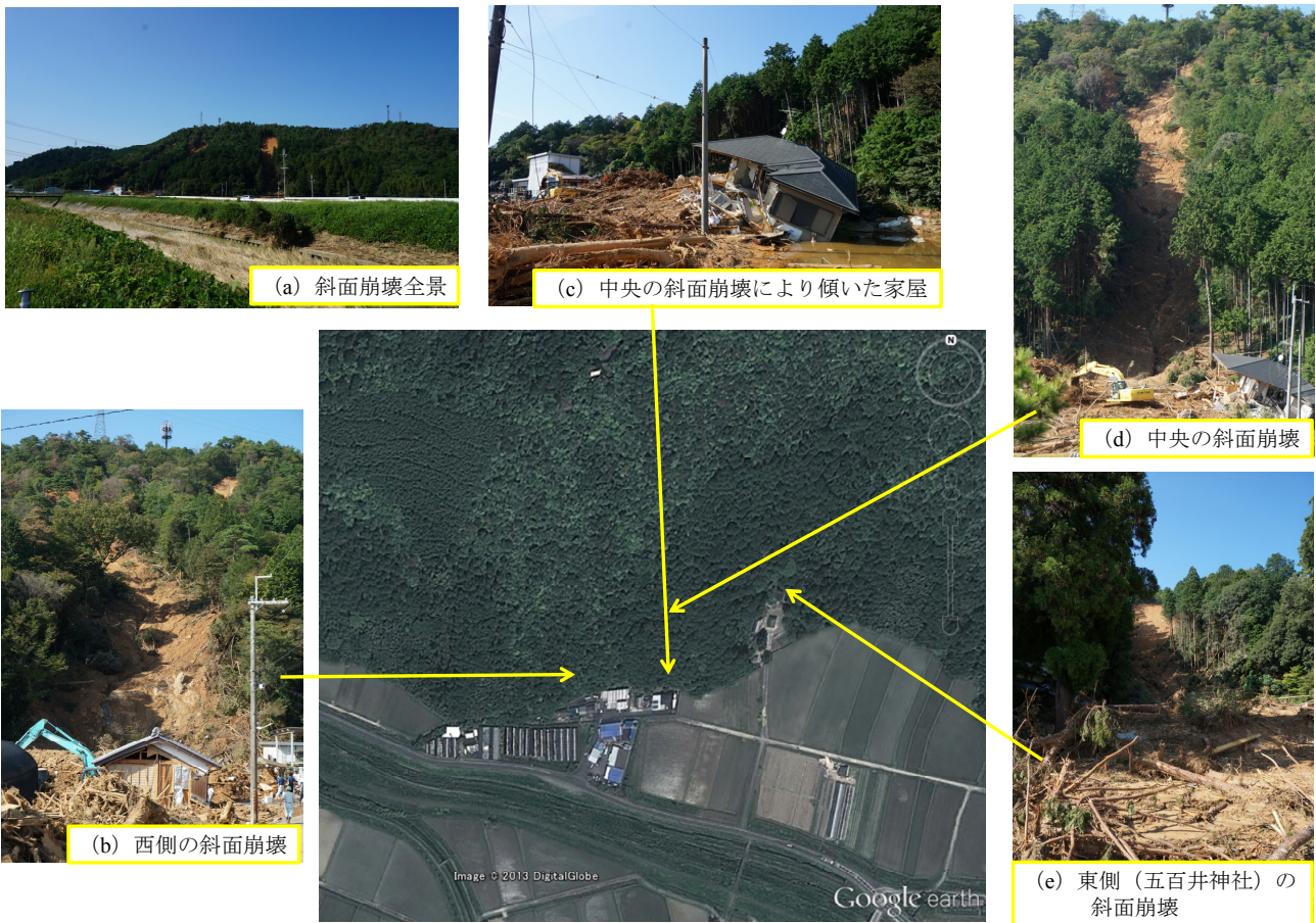
図-14 栗東市下戸山地区の斜面崩壊
