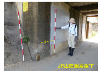
図-8 土師町の浸水(9/25)
