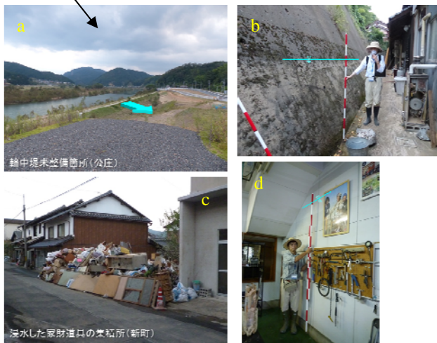
図-10 公庄地区の堤防未整備箇所と浸水痕跡、廃棄される家財道具(新町) および民家の浸水痕跡(蓼原) (9/21)
