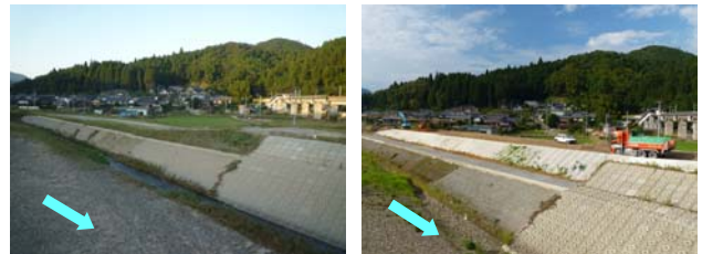
図-28 宮川の河川改修(拡幅)工事，堤防整備工事の状況 (2013/9/21, 2014/6/6)
