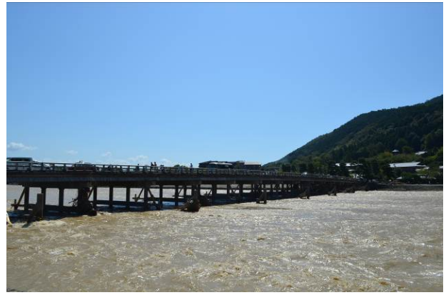
写真-2 桂川左岸上流側から見た渡月橋。橋桁の高さにまで流木が達している。
