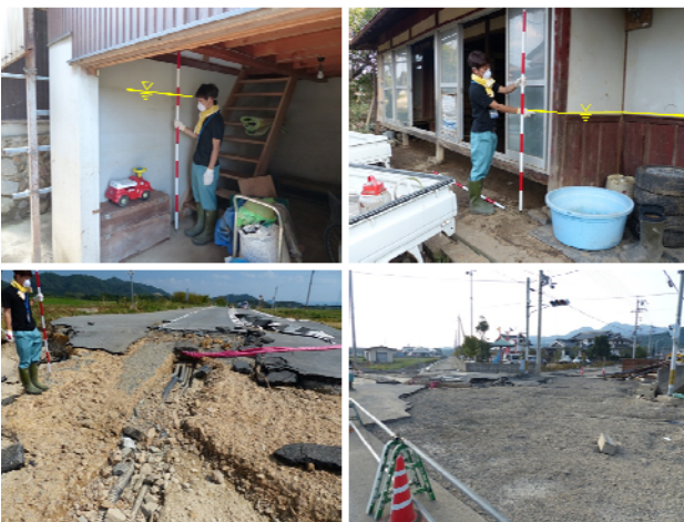
図-5 戸田地区周辺の民家浸水痕跡と道路破壊状況(9/23)
