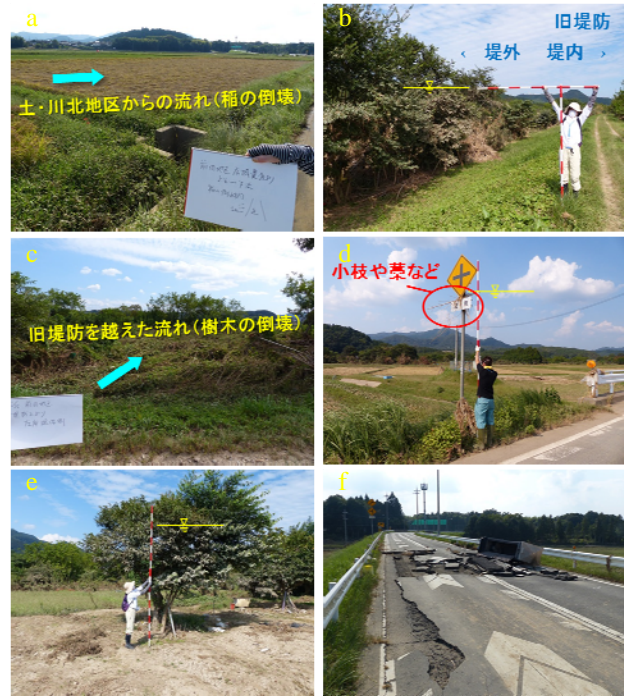
図-7 前田地区の旧堤防および農地の浸水状況(9/23・25)
