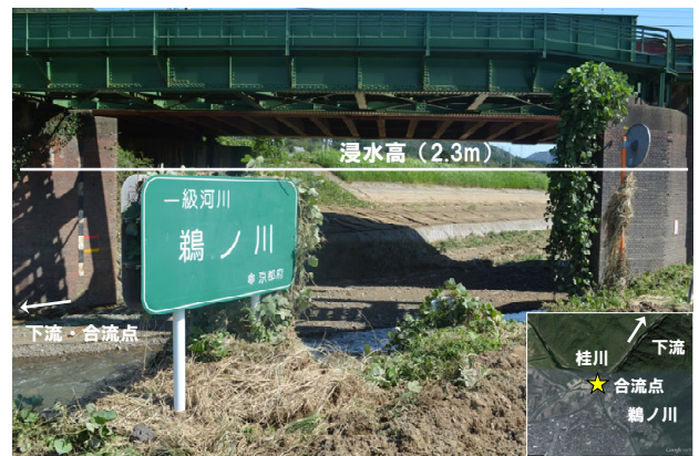
写真-4 桂川と鴨ノ川の合流点付近（保津峡上流側）
