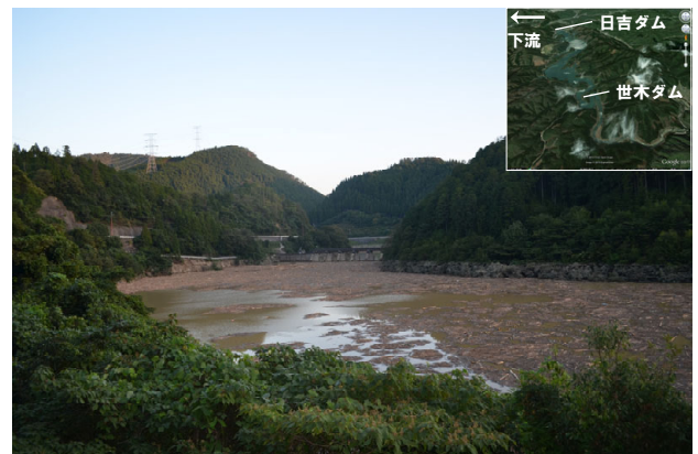
写真-7 世木ダム直下に滞留した流木
