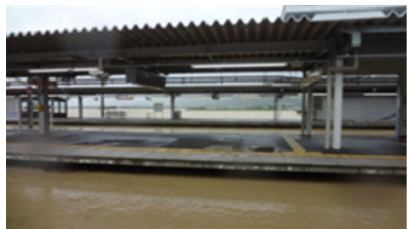
写真-8 ホーム下まで浸水した亀岡駅(堀智晴教授提供)
