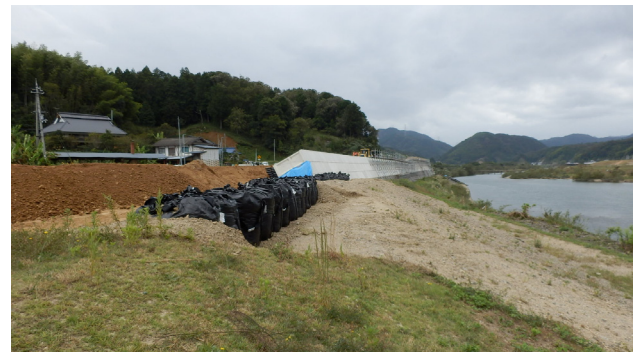
(c) 綾部市私市町右岸破堤箇所の仮復旧状況
