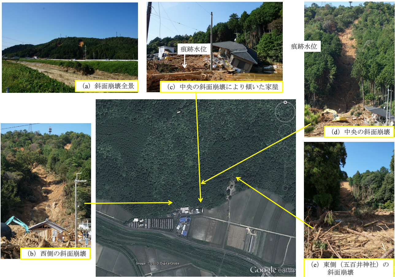
図33 栗東市下古山地区の斜面崩壊
