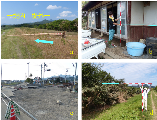
図24 河川水の流入箇所, 民家浸水痕跡, 道路損壊(a)～(c): 9/23撮影)および堤防未整備箇所(d): 9/25撮影)
