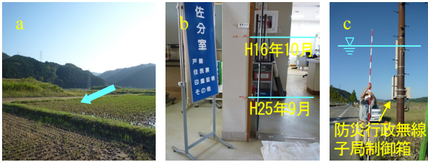
図30 志高地区の堤防未整備箇所，市役所分室の痕跡，防災行政無線(9/21撮影)
