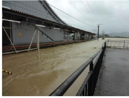
(b) JR亀岡駅北口（桂川側）より西（上流側）を望む
