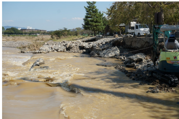
(f) 6号井堰上流右岸側の護岸の破壊
