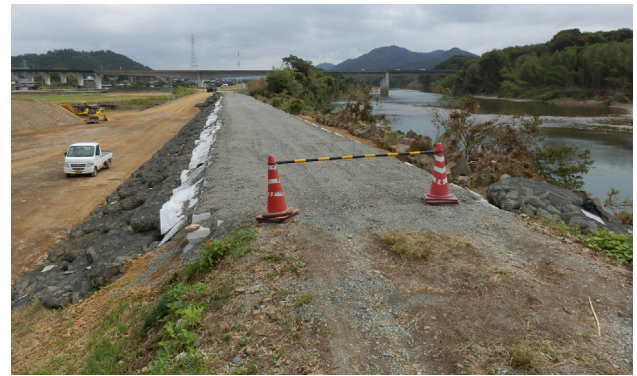
(b) 綾部市私市町右岸破堤箇所の仮復旧状況
