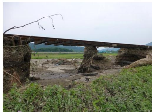
写真-2 線路盛土の被災状況，近景（8/16撮影）
