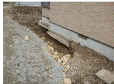
写真3 月布川からの洪水氾濫流による浸食(久保橋下流左岸側の民家)
