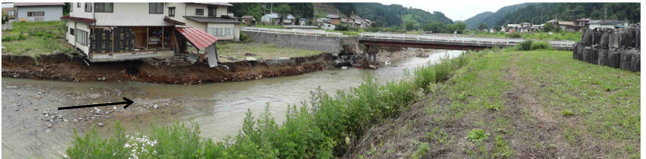
写真 3 吉野川金山地区での被災状況
