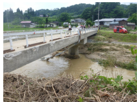
写真2 久保橋の冠水により集落が一時孤立(7/21時点)
