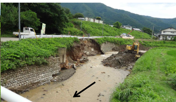
写真2 地点②での護岸決壊
