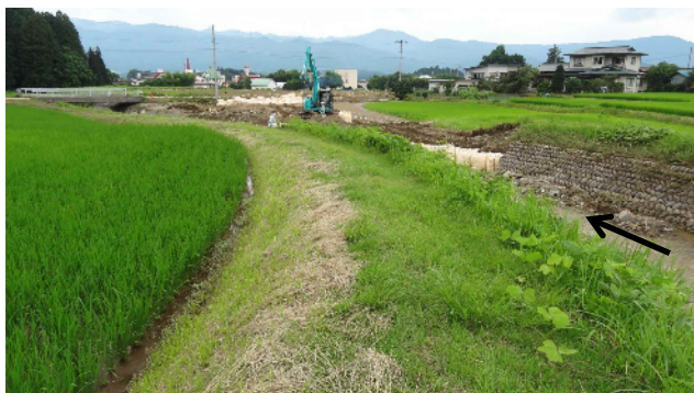
写真1 地点①での護岸決壊
