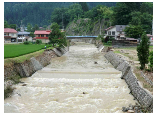
写真 1 石積み護岸の崩落被害の様子（図 1 赤点線下流部）
