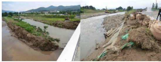
写真 1 石積み護岸の崩落被害の様子 (右写真：図 1①、左写真：図 1②)
