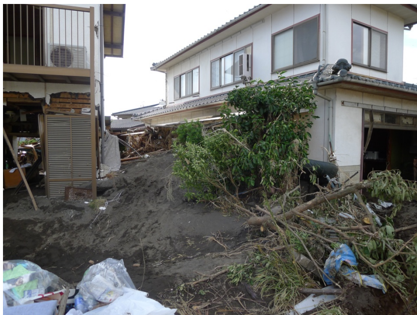
家屋周辺に堆積した土砂 撮影20120715
