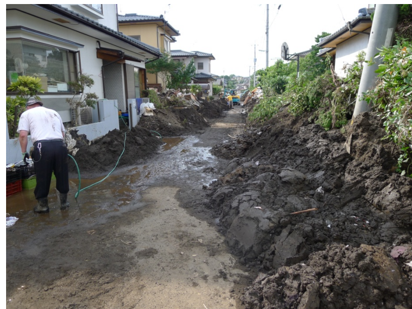
家屋から搬出された土砂 撮影20120715
