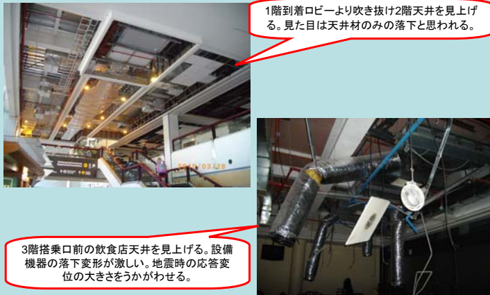
被害例1: 鉄骨構造建物での天井材落下 (サンチアゴ国際空港 国際線ターミナル 2010-03-28および04-05)
