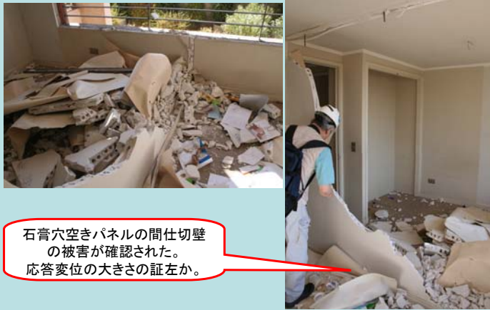
被害例7: 非構造壁の被害 (前出の被害例3: Edificio Sol Oriente 1 y 2)
