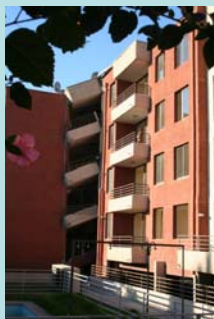
被害例1:ピロティの被害 (サンチアゴ近郊 マイブ Edificio Don Luis 2010-03-28)
