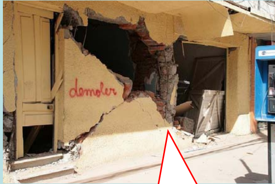
被害例3: 枠組み組積(RM)造の被害 (タルカ市内 2010-03-30)
