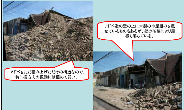
被害例2: 日干しレンガ(アドベ)造建物の被害 (タルカ市内 2010-03-30)
