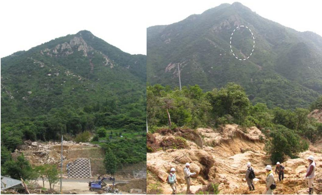
写真-5e.1 (左) 国道東側斜面(右田ヶ岳)で発生した土石流とプレキャスト法砕工
