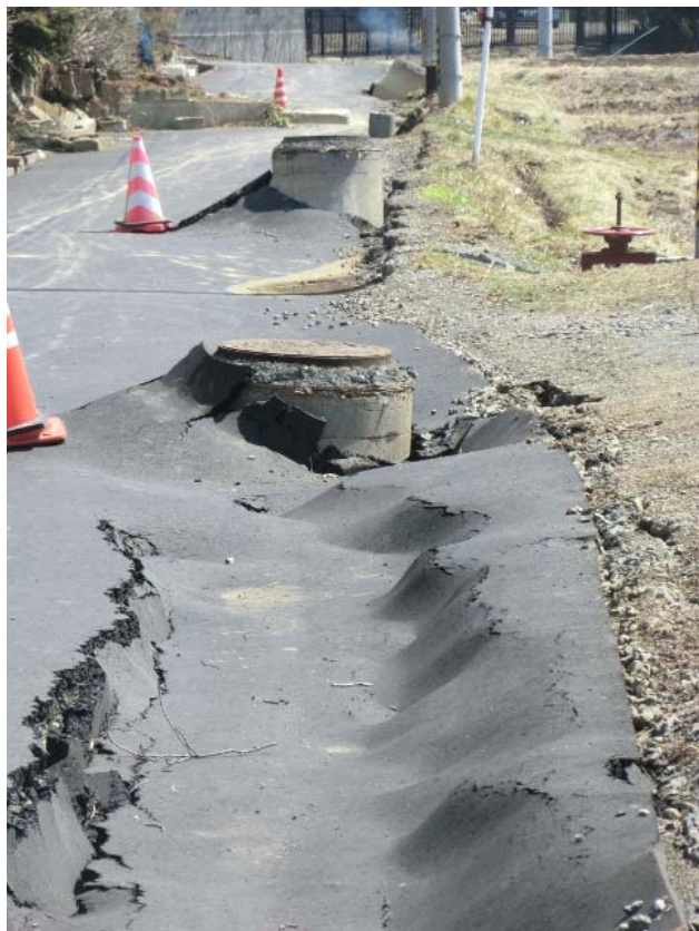
埋め戻し土の液状化
