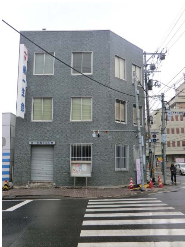
液状化による建物の傾斜
