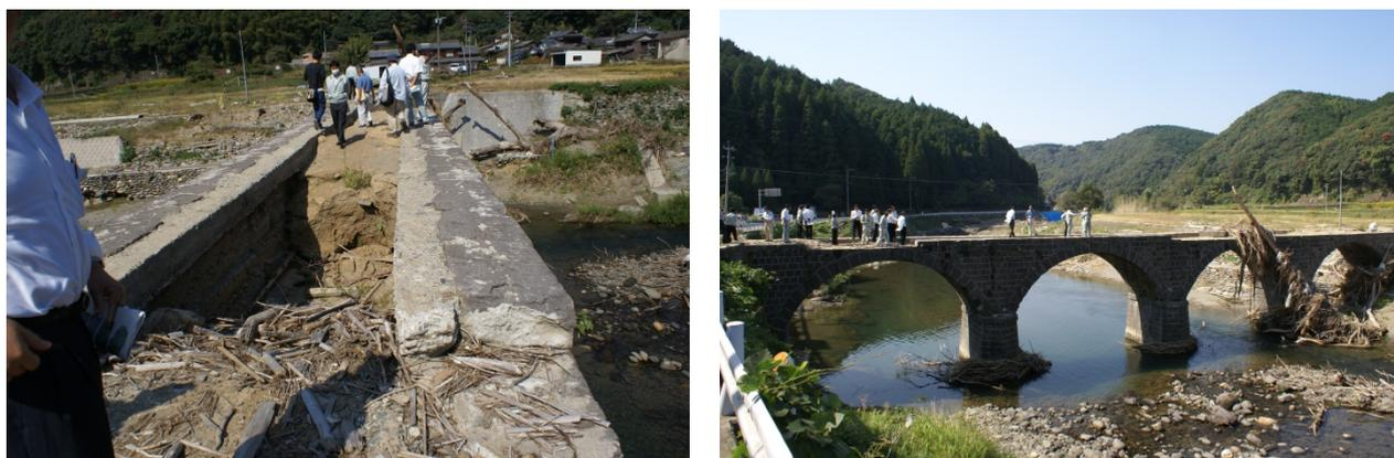
図 1.2 石橋の被災状況（星野川宮ヶ原橋(4連眼鏡橋)．左：桁上面，右：全体．平成 24. 10. 16 撮影)
