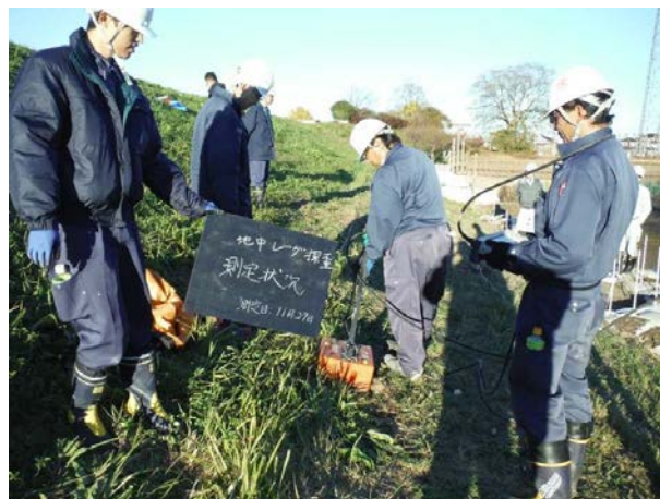
地中レーダ探査
