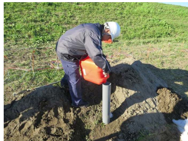
噴砂地点への注水状況
