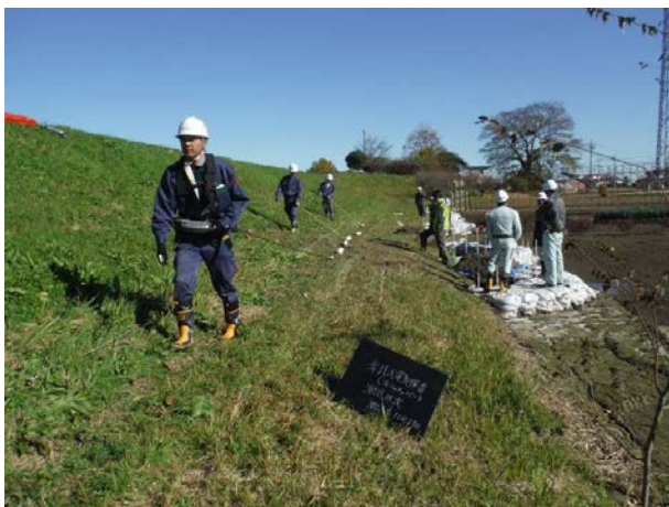
牽引式電気探査
