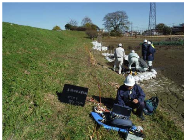
電極打設式電気探査
