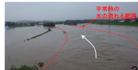
標茶地点 (KP46付近) 河道状況
