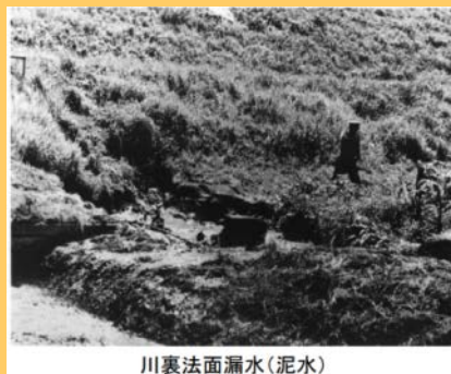
川裏法面漏水(泥水)
