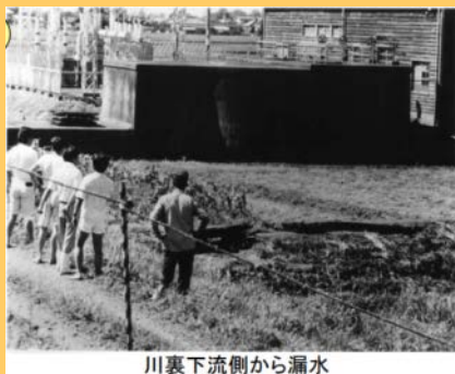
川裏下流側から漏水
