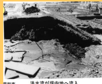
常総市 洪水流が堤内地へ流入
