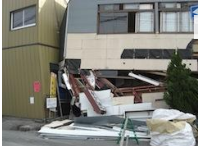
鉄骨店舗兼住家の倒壊
