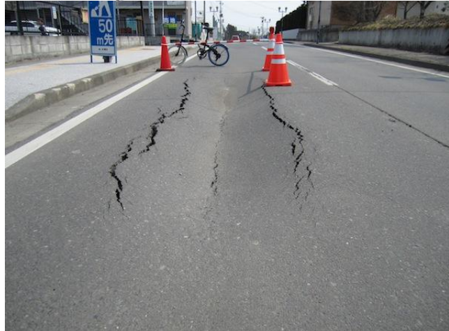
路面の陥没
