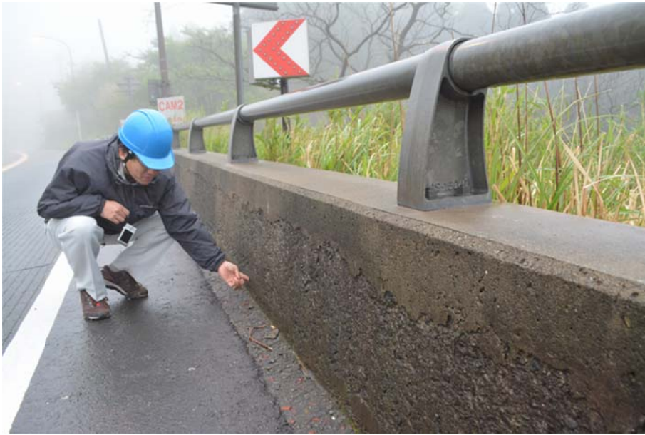
写真 5 防護柵の凍害による劣化状況
