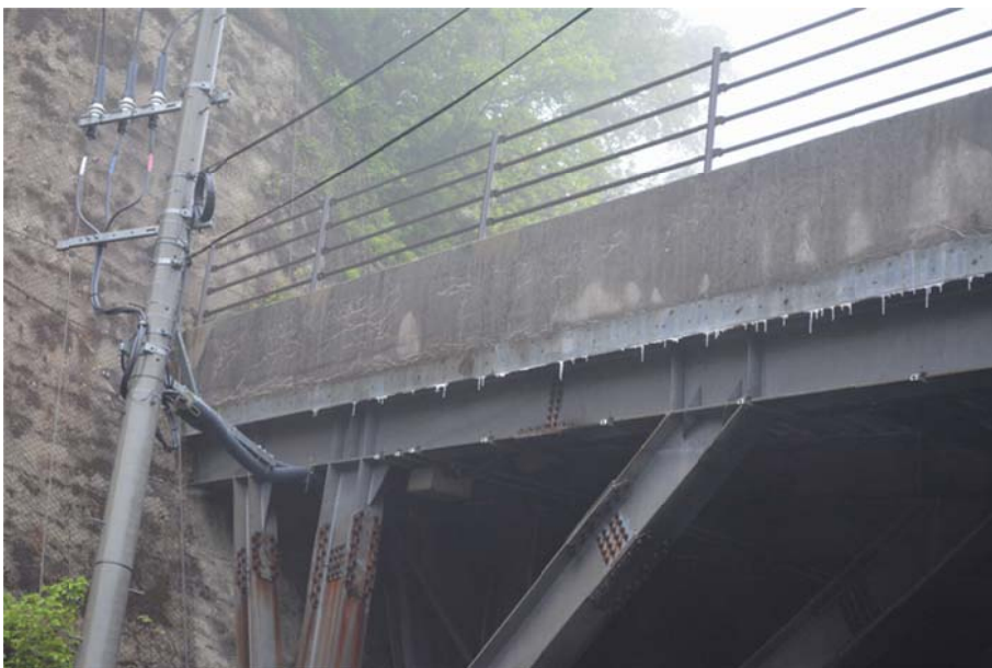
写真 6 中腹部のロックシェッドの入口の劣化
