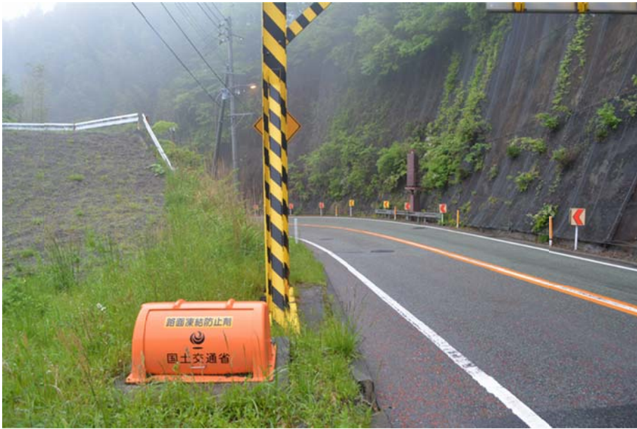
写真3 路面凍結防止剤の貯蔵庫
