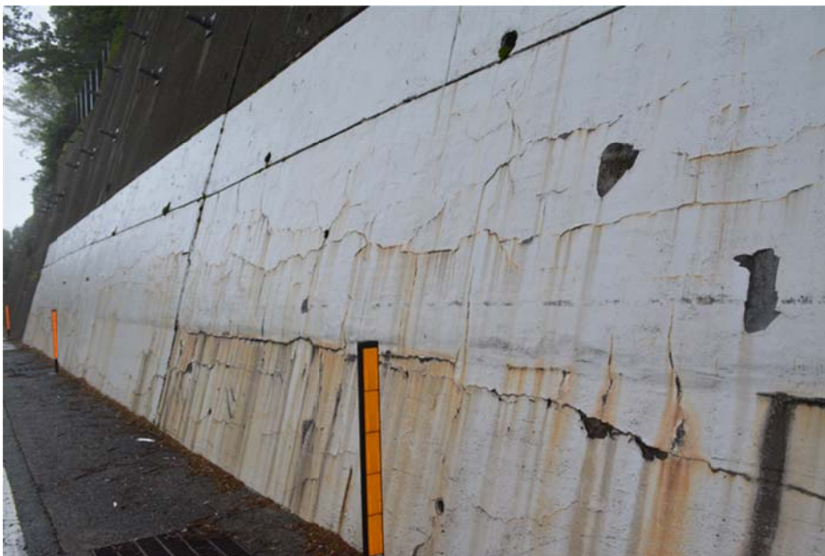
写真4 ASRにより劣化したと思われる擁壁
