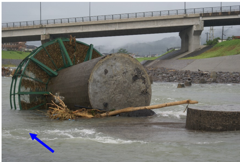
右から3番目の橋脚
