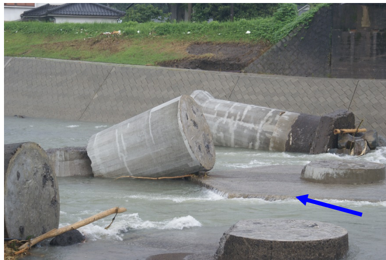
右から1, 2番目の橋脚
