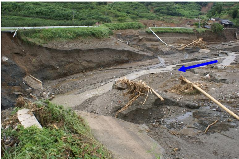
溜池右岸側の護岸の損傷
