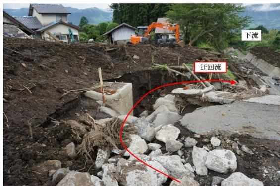
図 5.10 迂回流による河岸の浸食
