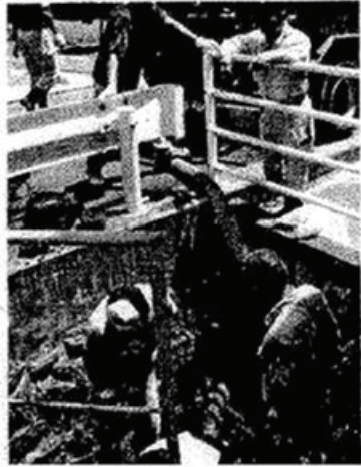
マンホールから噴出した汚泥が、に詰まり、除去作業に当たる作業員ら
