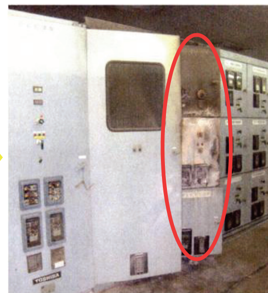
火災発生盤 正面
