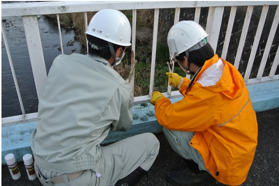
橋梁補修の実施研修
