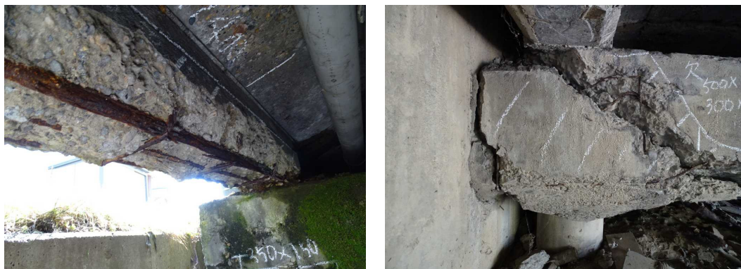
図 5.1.7 IV判定の豊栄 1-106 号線 1 号橋の損傷写真
