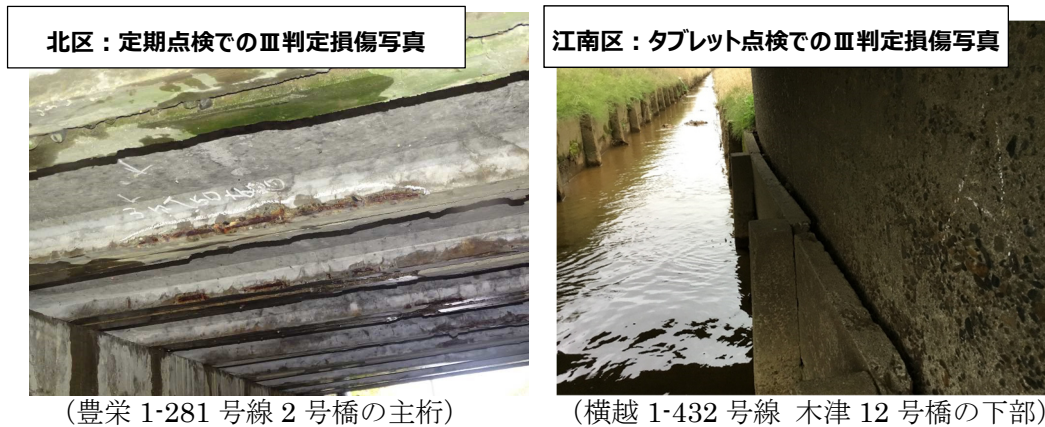
図 5.1.6 北区・江南区それぞれのゾーン④に位置した損傷例
