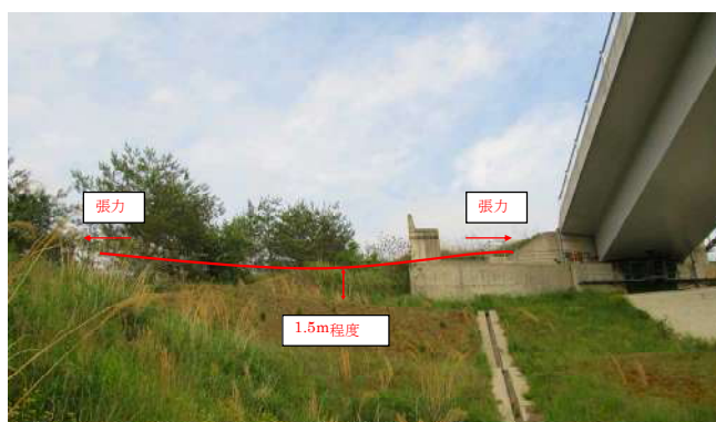
図4.2.2 通信ケーブル等の配置方法の例
