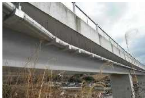
写6.2 箱桁外面の状況
