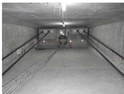
写6.1 箱桁内面の状況
