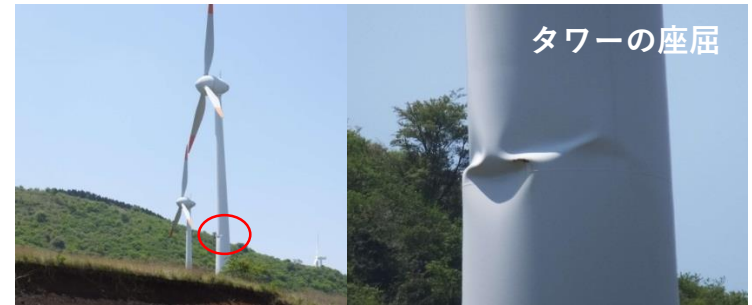
久木野風力発電所（熊本県）
