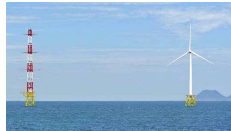
響灘【着底式】 2013 日本製鋼所 2MW
