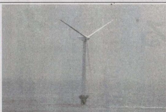
東電が実証試験を進める洋上風力発電設備（22日、千葉県銚子市）
