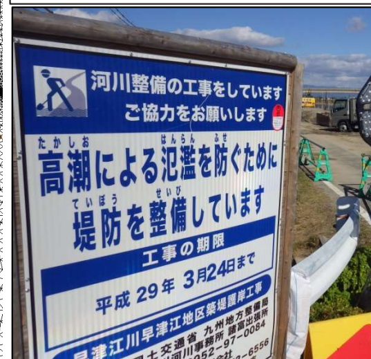
海岸堤防 整備中箇所
