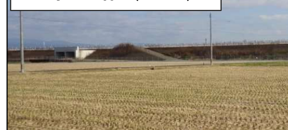
沿岸道路（盛土）
