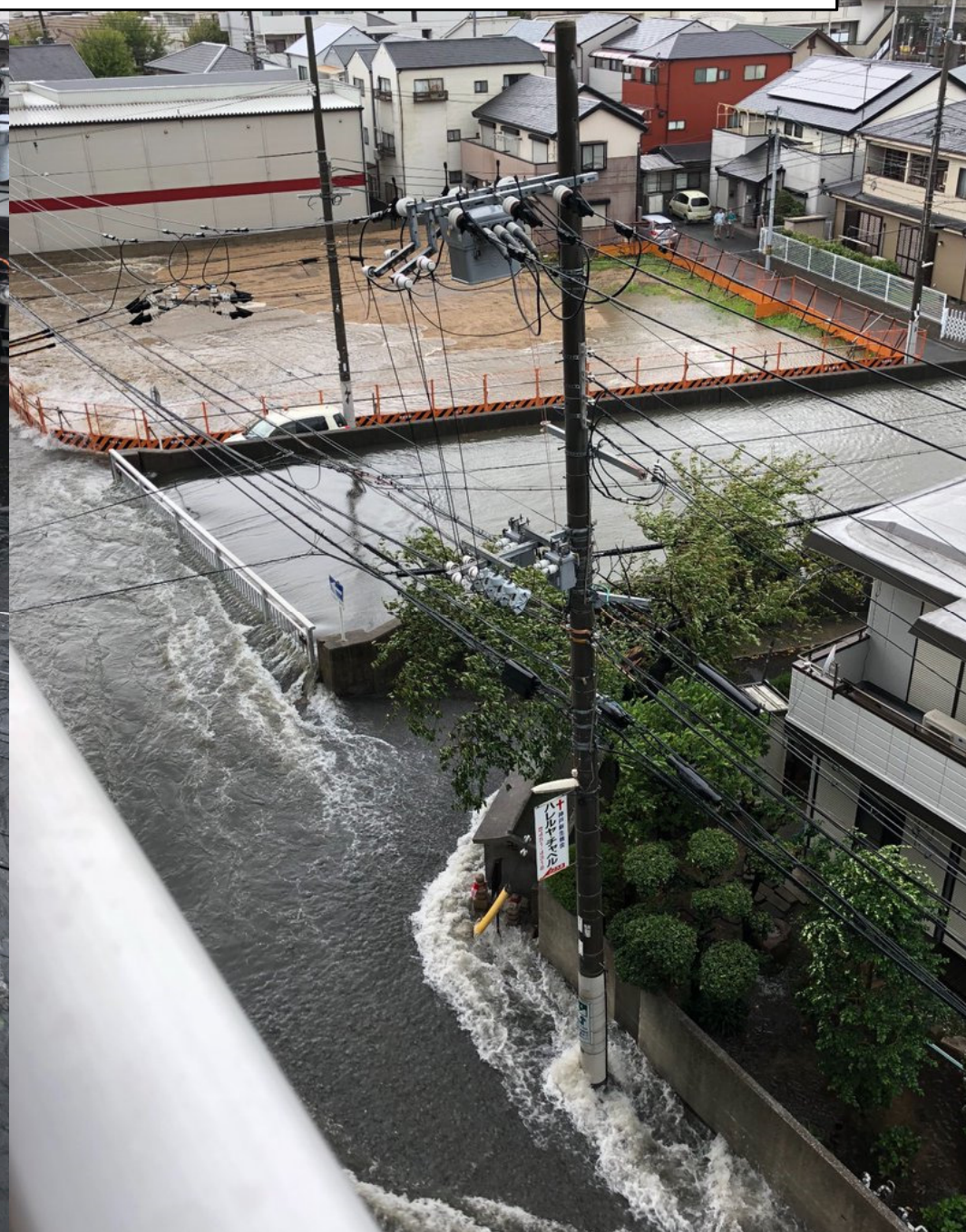
深江橋南東より
