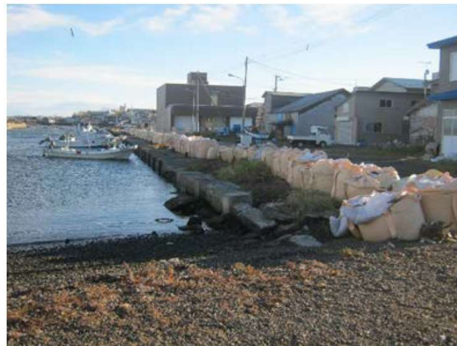
写真-2.6 弥生町③（物揚場背後に積んだ土のう）
