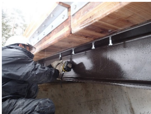
図-15 CLT床版の固定
