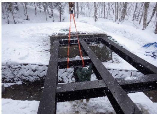
図-13 主桁・横桁の架設
