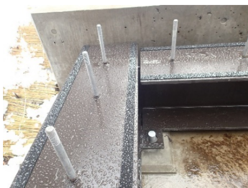
図-16 桁端部のスタッドボルト
