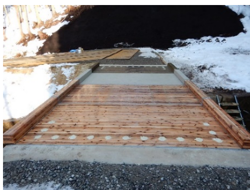
図-17 舗装前のCLT床版
