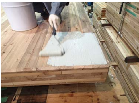
図-7 ポリマーセメントによる被覆処理
