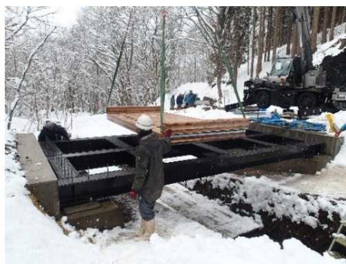
図-14 CLT床版の架設
