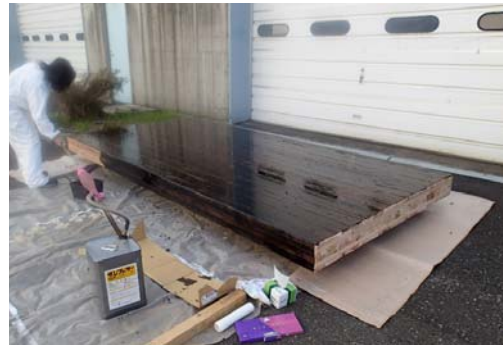
図-8 塗布型防腐処理薬剤による塗布処理
