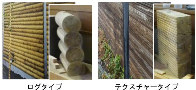
図-2 木製遮音板の断面形状
