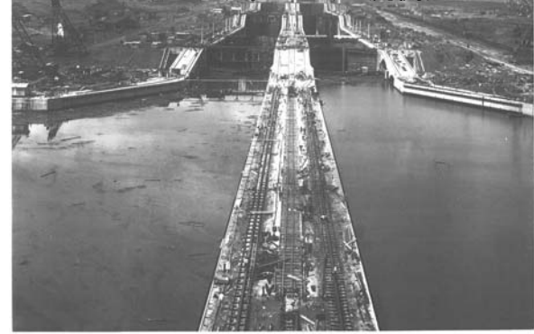
青山士設計 ガトゥン閘門 中央隔壁アップ ローチ・ウォール(下流側)
