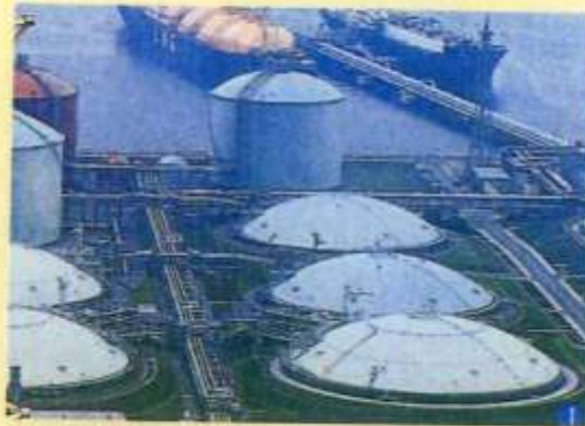
LNG tank LNGタンク
