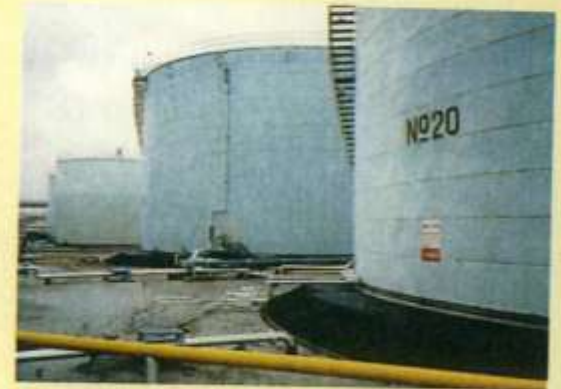
Oil tank 油タンク
