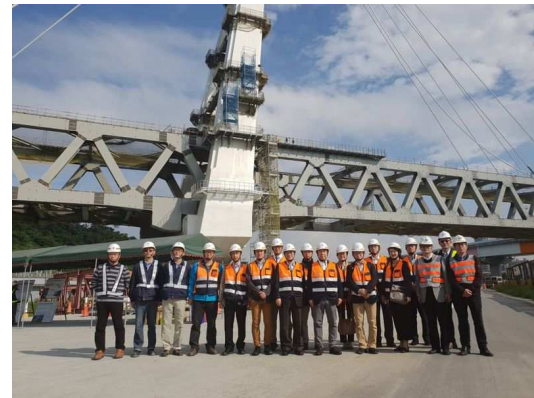
台湾橋梁工事現場にて
