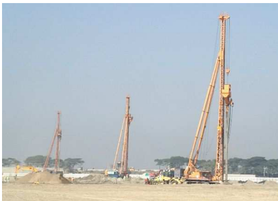
SCP 施工状況
