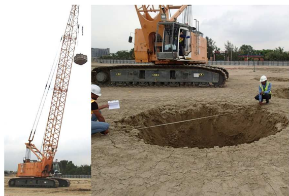
DC 施工状況
