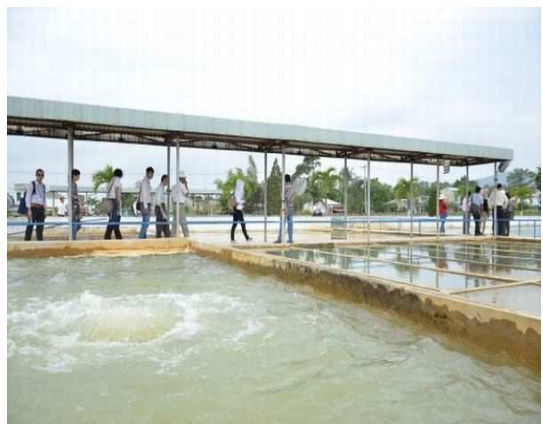
Cau Do 浄水場の視察 (ダナン、ベトナム)
