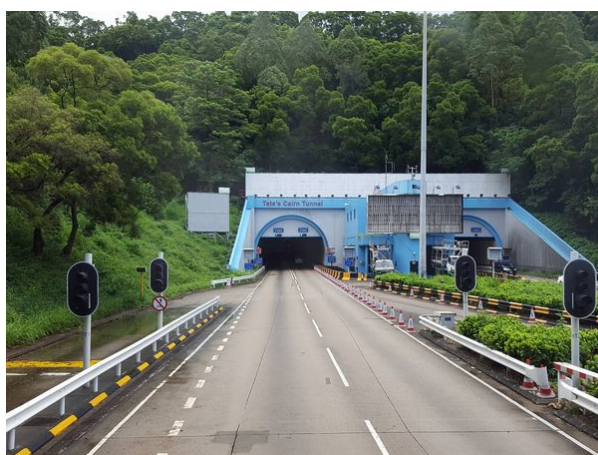
テーツケントンネル (TCT)外観
