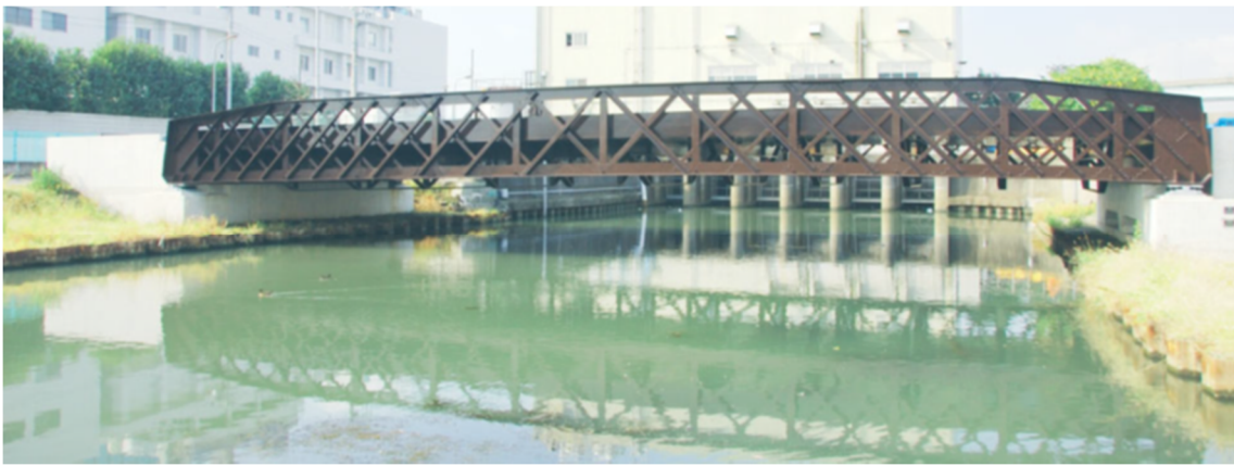
写真 1 東京都江戸川区に架かる西水門橋
