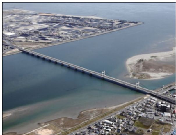
写真1 阿波しらさぎ大橋
