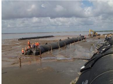
写真2 干潮時の最下段のジオチューブの敷設作業
