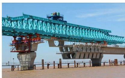
写真 8 吊り能力 1400t の架設桁によるセグメント吊下げ
