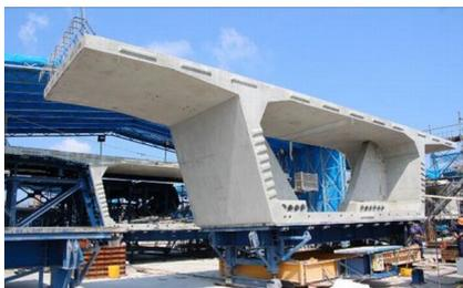
写真 7 ショートラインマッチキャストで 1,405 個の径間セグメントを製作
