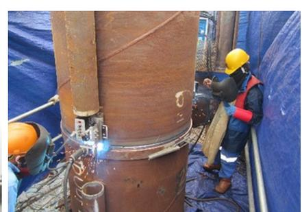
写真6 2台の自走式溶接装置による現場円周溶接
