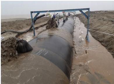
写真1 ジオチューブの充填作業
