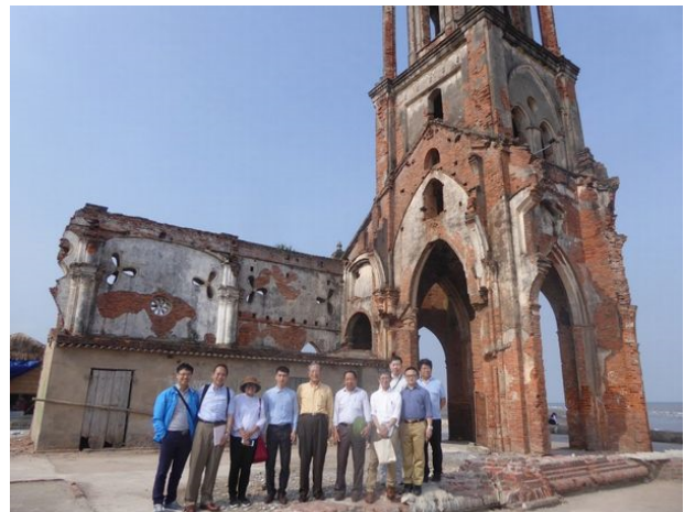
写真 1 海岸浸食と台風被害により崩壊した ナムディン省 Hay li 地区の教会
