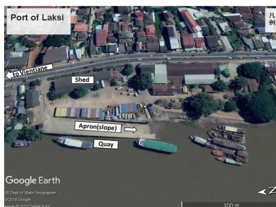
ラクシ (Laksi) 港： 貨物船の岸壁への接岸、荷役がメコン川の水位変化に対応できるように、岸壁・エプロンは斜路形式 （写真は高水位期）
