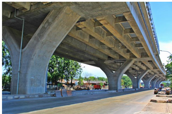
写真-2 橋脚 P20 から P25 付近の Y 型橋脚
