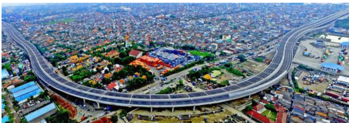
写真-1 上空からみたタンジュンプリオク港アクセス道路 E2 高架橋
