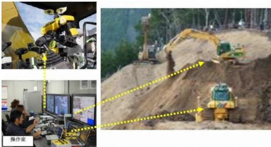
災害復旧で用いられる無人化施工技術
