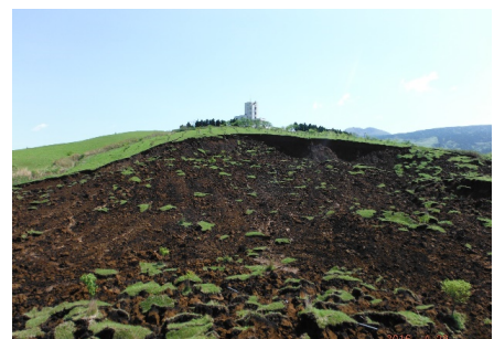
写真 4 緩傾斜な斜面で発生した地すべり性崩壊
